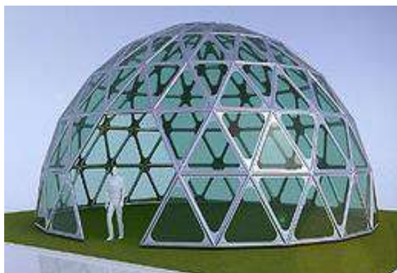
Рисунок 4 – Конструкция геодезического купола.
