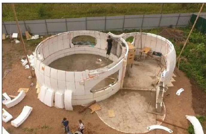
Рисунок 6 – «Несъемная опалубка»
