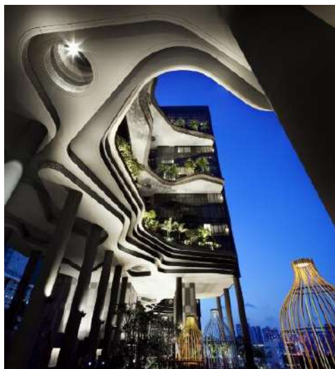
Рисунок 4 – Вид с 5-го уровня здания на террасы
