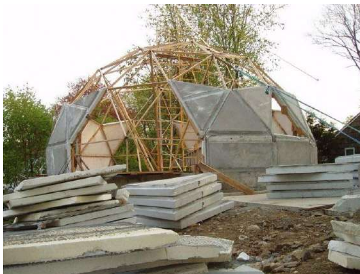
Рисунок 7 – «Сборка купольного дома из заводских блоков»
