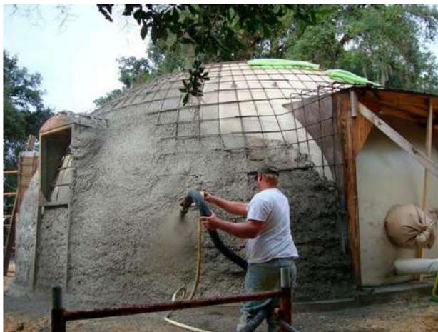
Рисунок 5 – «Распыление цементной смеси спецоборудованием»
