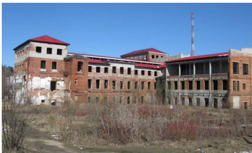
Рис. 2. Здания бывшей льнопрядильной фабрики, начало XXI в.
