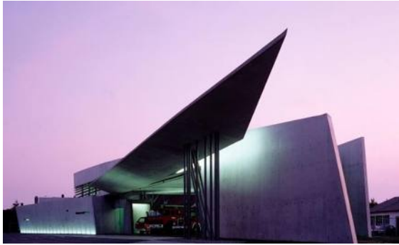
Рис. 1. Пожарная станция фабрики Vitra (Вайль-на-Рейне, Германия, 1993)
