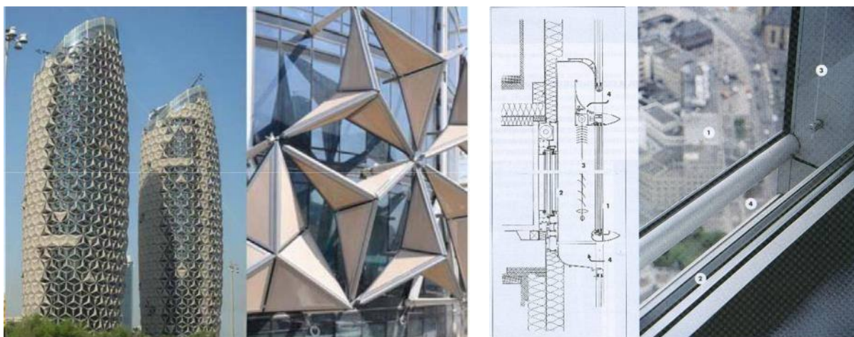
Рис. 3. Динамические фасадные системы. «Al Bahar Towers», Абу-Даби.
