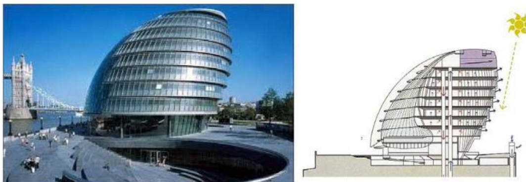
Рис. 2. Здание «City Hall», Англия. Обеспечение самозатенения с помощью архитектурного образа
