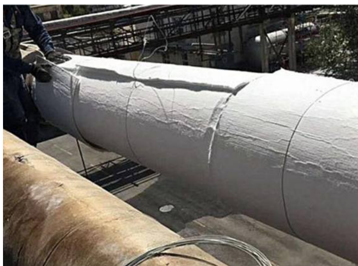
Рис. Теплоизоляция трубопровода аэрогелем
