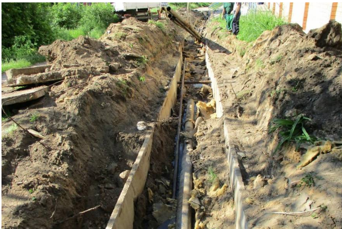
Рис. 1. Демонтаж плит перекрытий и магистрального теплопровода
