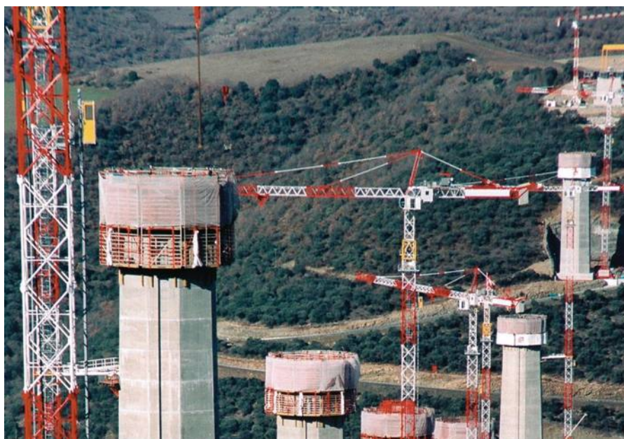
Рис. 2. Бетонирование опор
