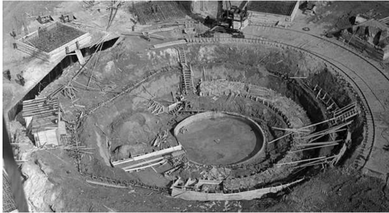
Рис. 2. Разработка котлована под фундамент башни
