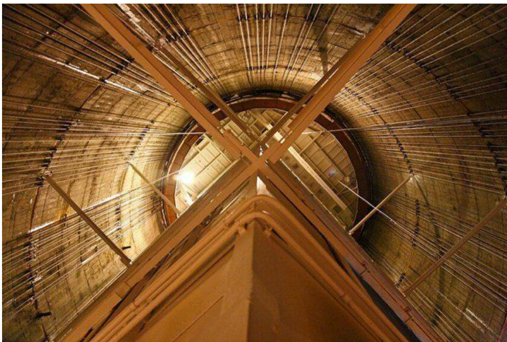
Рис.3. Натянутые канаты внутри башни
