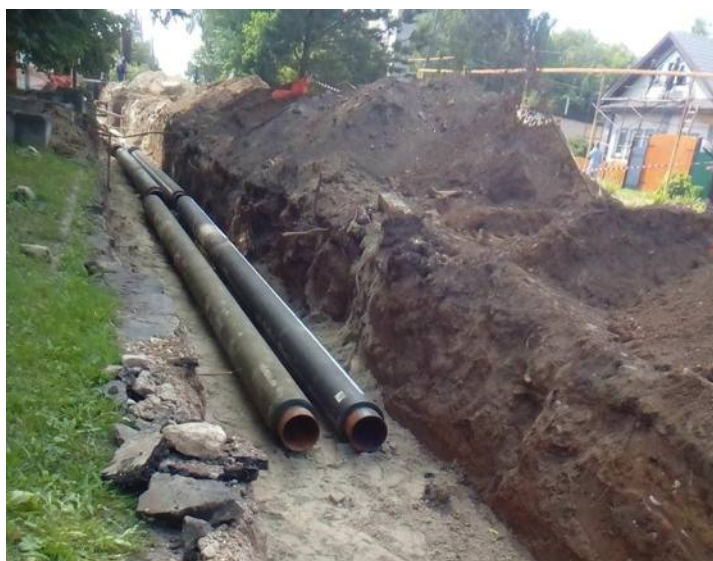
Рис. 4. Бесканальная прокладка магистрального теплопровода из ППМИ
