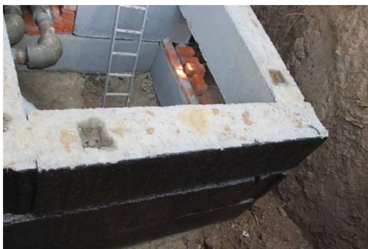
Рис. 5. Гидроизоляция наружных стен тепловой камеры
