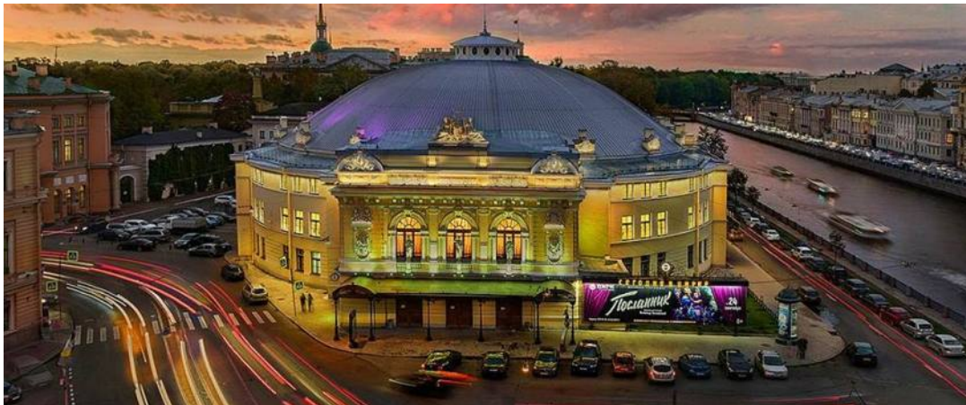
Рис. 3 Современное состояние здания Большого цирка на Фонтанке в Санкт-Петербурге.
