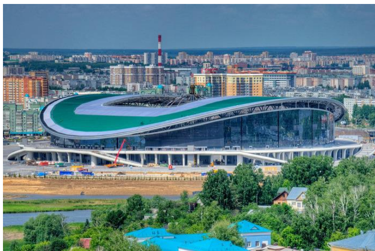
Рисунок 2 – Светопрозрачные конструкции на стадионе «Казань-арена».
