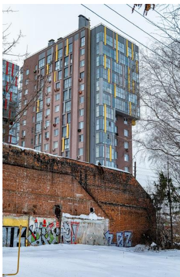
Рисунок 11 – Соседство старого и нового на ул. Ильинской, фото И. Старков
