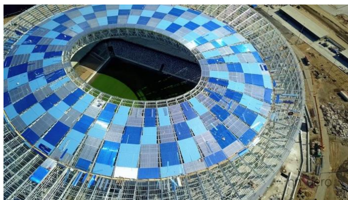
Рисунок 3 – Поликарбонат на покрытии стадиона «Нижний Новгород арена». Более общие положения по стадионам приведены в таблице 2.
