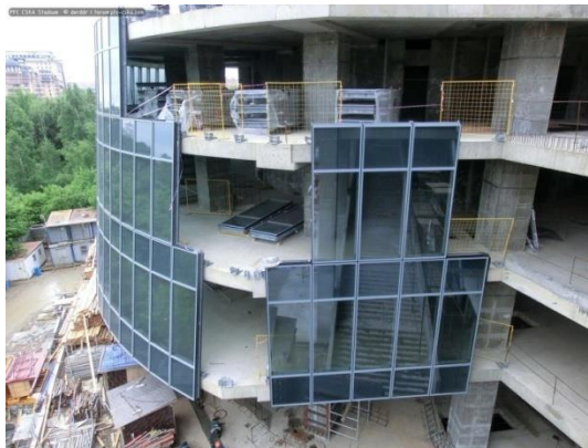
Рисунок 1 – Система фасадного остекления на стадионе «ВЭБ арена».
