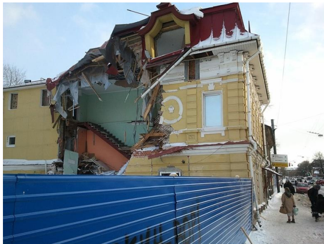
Рисунок 10 – Снос исторического дома №126 по улице Ильинской
