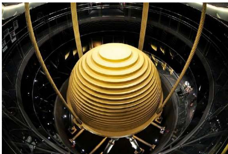
Рис.2 – Устройство амортизатора в небоскрёбе «Тайбэй 101»
