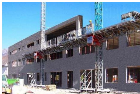
Рис.2 Возведение здания с помощью портального 3D - принтера
