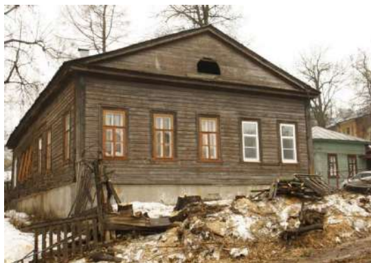
Рис. 1. Главный фасад флигеля. Ул. Семашко д. 21А
