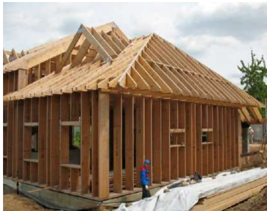
Рис. 5 – Здание каркасного типа
