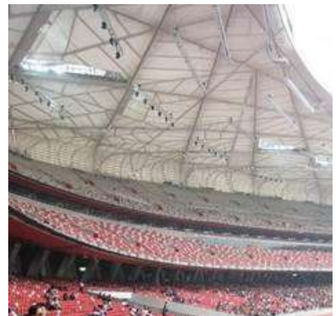
Рис.4.Переплетение с натянутыми пленками из этилентетрафторэтилена
