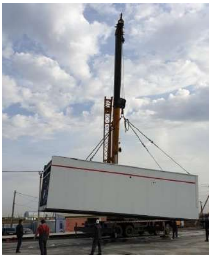
Рис. 1. Установка БМК с помощью крана
