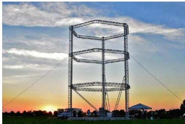
Рис.4 Возведение здания с помощью Дельта – 3D – принтера
