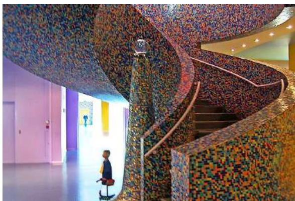
Рис. 3. Облицовка лестницы мозаикой.
