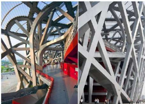
Рис.3.Криволинейные коробчатые секции, сваренные в единую конструкцию фасада
