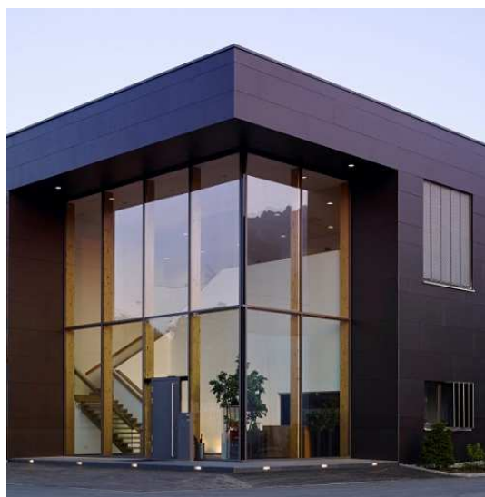
Рис. 3. Система энергосберегающего остекления
