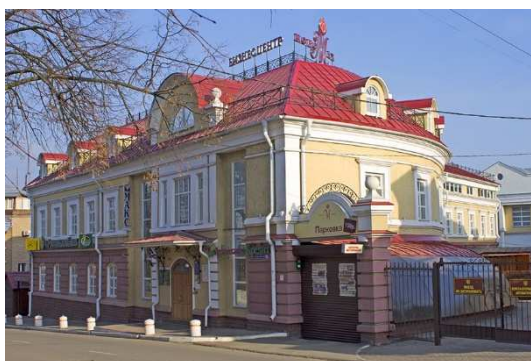
Рис. 3. Общественное здание (ул. Большая Московская, 1Б)
