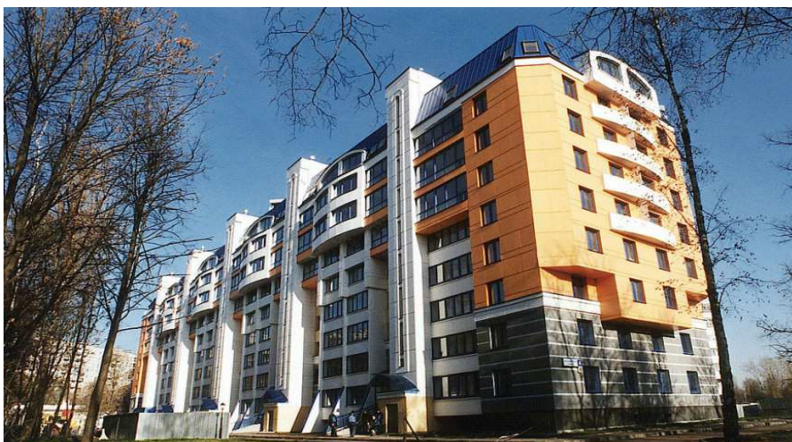
Рис. 3. Дом № 4 на Химкинском бульваре после реконструкции
