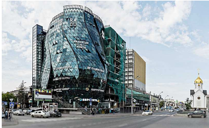
Рис. 6. Бизнес центр «Бутон», Новосибирск, 2011 г., арх. В. Филиппов, Е. Савин, К. Фроленок
