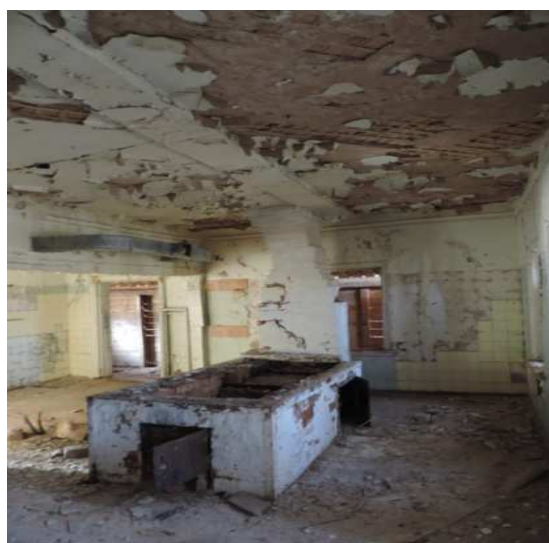
Рис. 3. Состояния перекрытий (фото автора, апрель 2019 г.)
