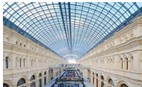
Рис.8 Арочные конструкции с тросовыми затяжками. ГУМ.
