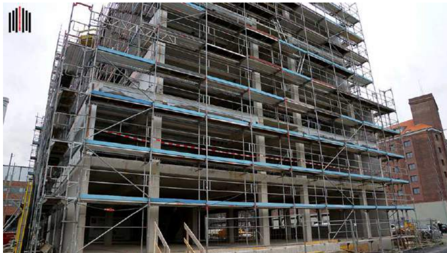
Picture 2. H7 Büro- und Verwaltungsgebäude, Münster
