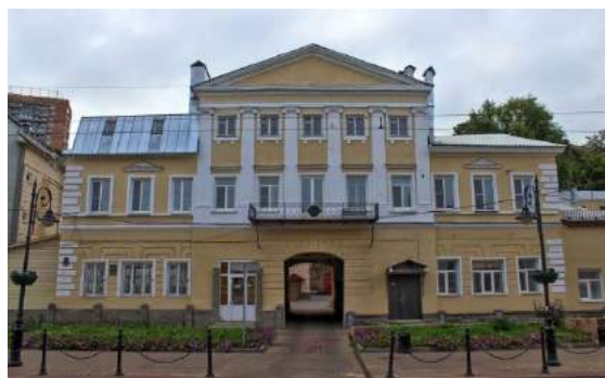
Рис. 2. Нижний Новгород, ул. Рождественская, д. 28. Доходный дом М. Смирновой, арх. И. Е. Ефимов, 1823 г.
