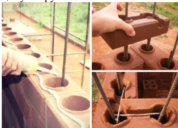
Рис. 5. Пример армирования конструкции из лего-кирпичей
