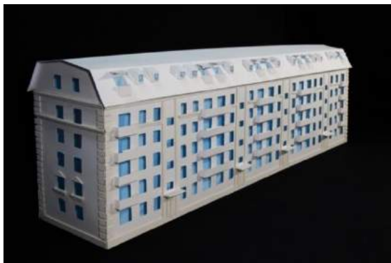
Рис. 5. Макет реконструированной «хрущёвки» с надстройкой мансарды
