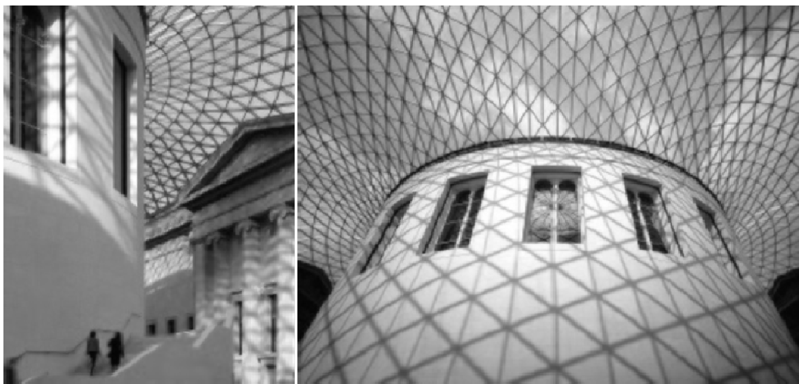
Рис. 1. Виды со двора на новое покрытие
