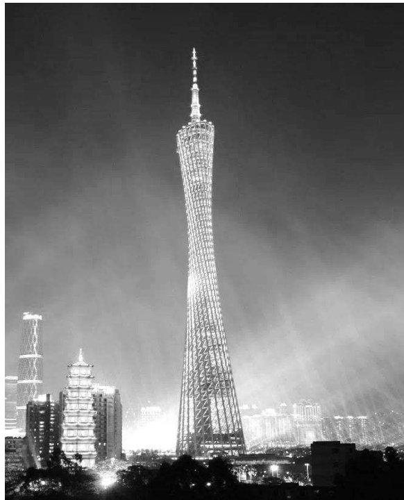
Рис.1. Телебашня Гуанчжоу. КНР. 2010 г.
