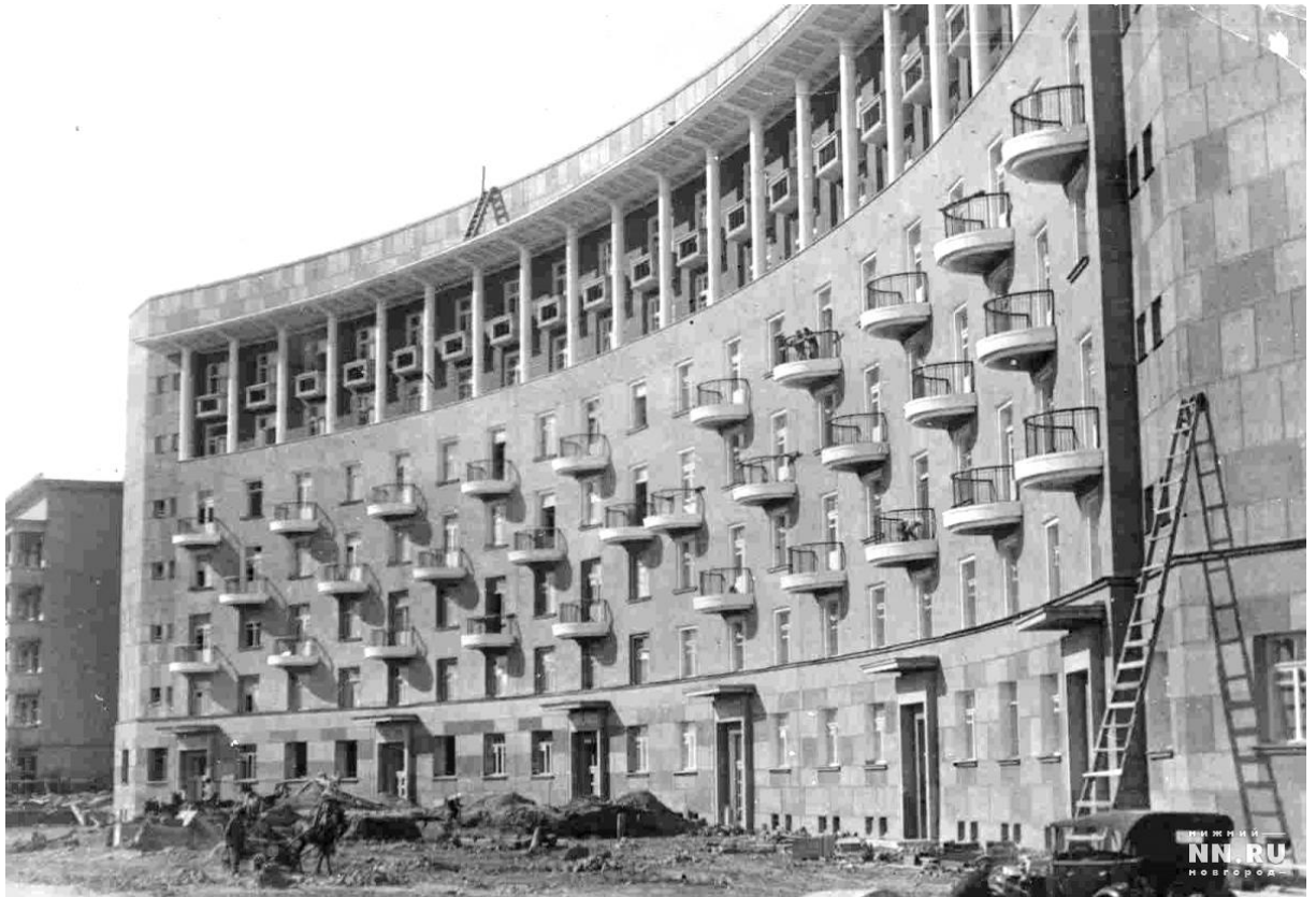
Рис. 2. Радиусный дом. Строительство дома
