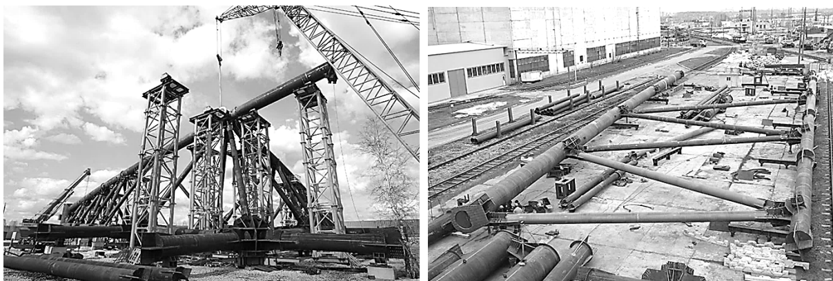
Рис. 5. Устройство металлических конструкций «Открытие Арена»
