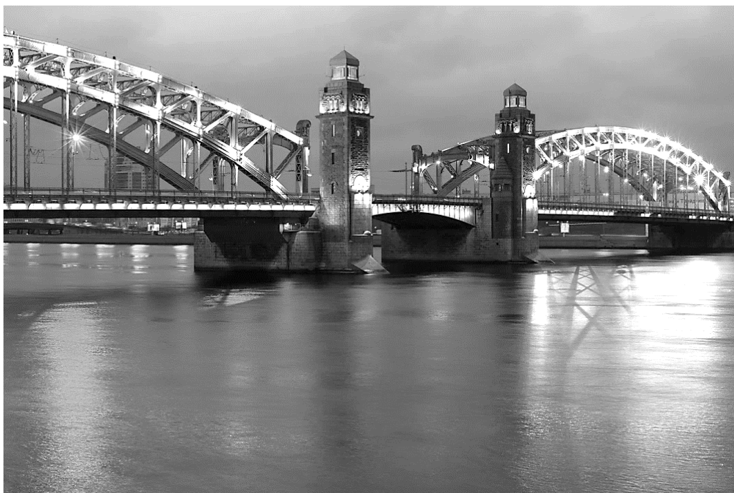
Рис. 4. Большеохтинский мост в Санкт-Петербурге после реконструкции в 2008 г.
