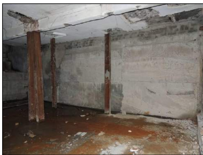
Фото.5. Монолитная железобетонная односторонняя обойма-«рубашка», выполненная вдоль стены, ориентированной по оси «А».
