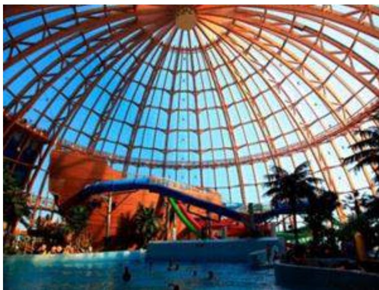
Рис. 1. Деревянный купол из ребер сквозной конструкции
