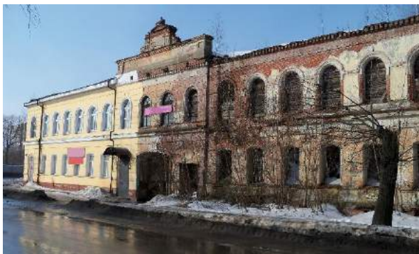
Рис. 1 Исходное фото здания
