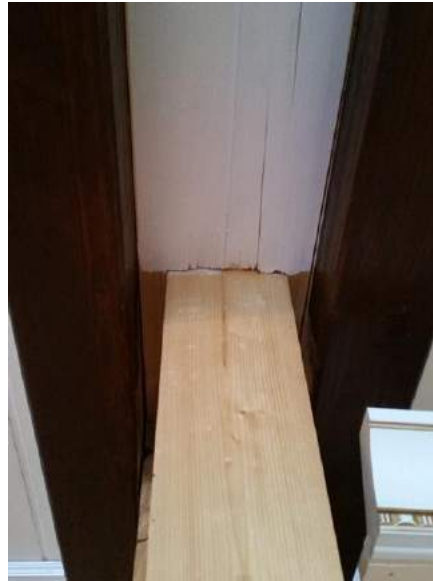
Рис. 1. Срез крайних волокон древесины опорой
