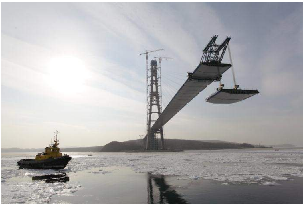
Рис. 2. Монтаж металлической балки жесткости с помощью деррик-кранов
