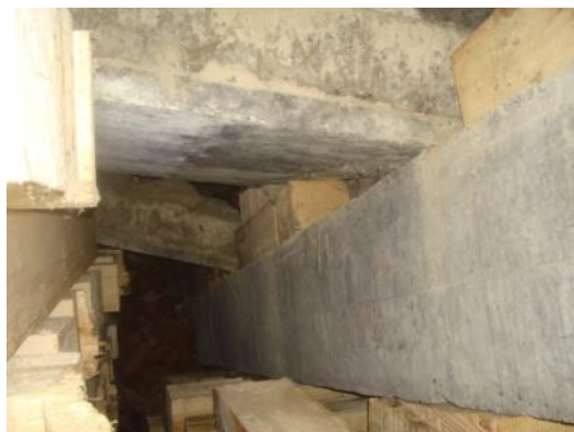
Рис.4. Фиксации обрушившихся конструкций в положении, зафиксированном на момент обрушения
