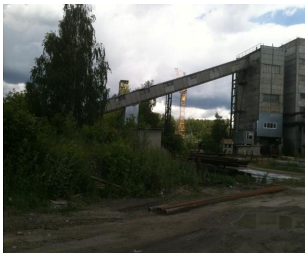
Рис.3. Крытый ленточный конвейер
