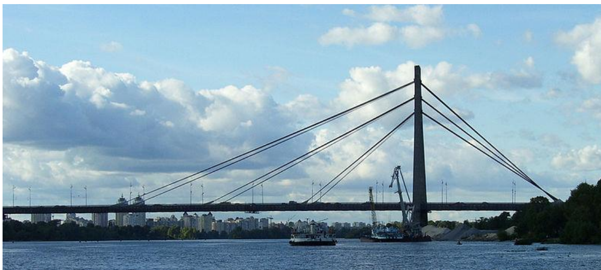
Рис.4. Вантовый Московский мост через Днепр в Киеве
