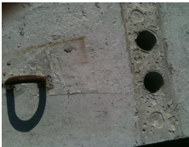
Рис.3. Два сквозных отверстия, рядом строповочная петля
