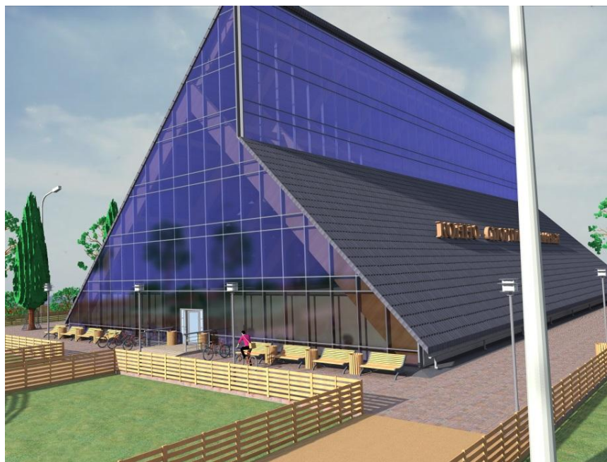
Рис.2. Общий вид здания
