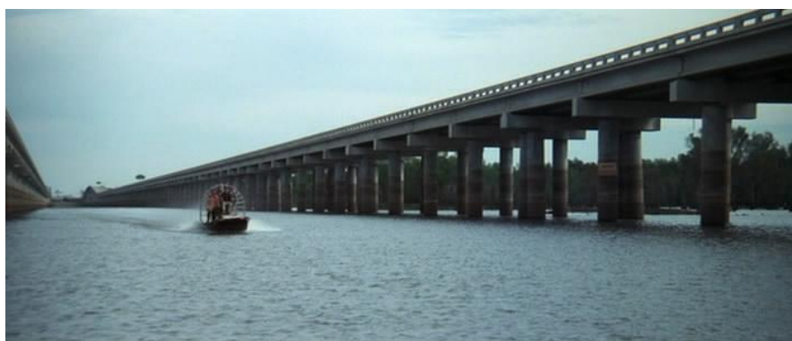
Рис.1 Балочный мост-дамба через озеро Пончартрейн в США
