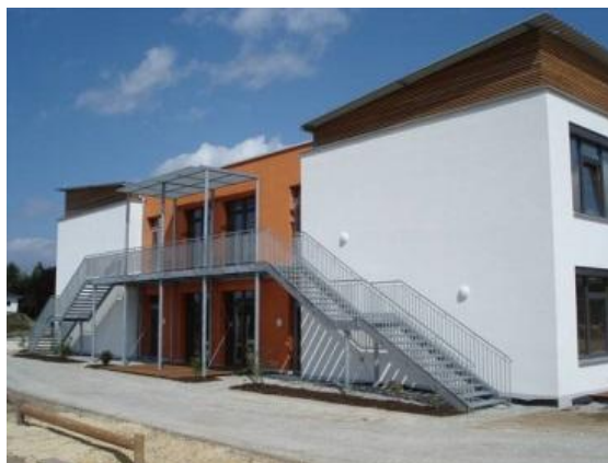
Рис. 5 Начальная школа «Зюд-Ост», Германия, вид с юго-востока
