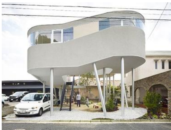
Рис. 4. Дом TodaHouseinHiroshima в г.Хиросиме, Япония, архитектор Кимихайко Окада.
