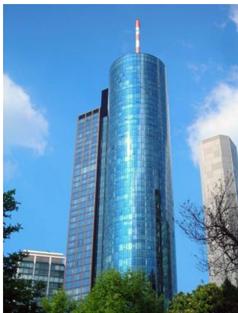
Рис. 4. Башня «Main tower», Франкфурт-на-Майне, Германия, архитектурное бюро «Швегер & Партнер»
