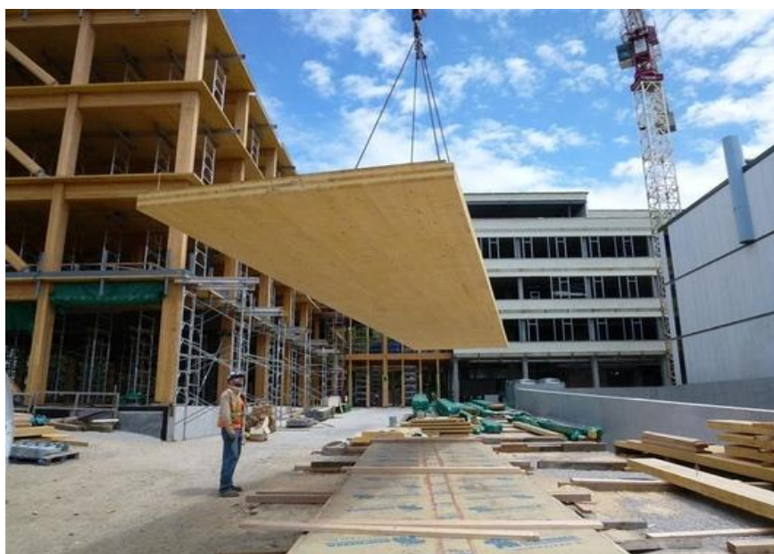
Рис. 1. Строительство высотного жилого дома из дерева
