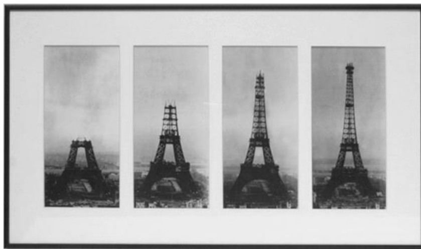
Рис. 2. Сооружение Эйфелевой башни
