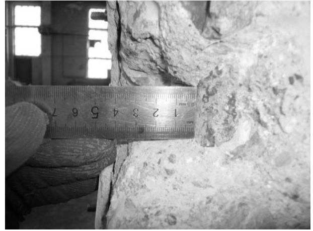
Рис. 3. Величина защитного слоя арматуры 40 мм. Диаметр арматуры 28 мм
