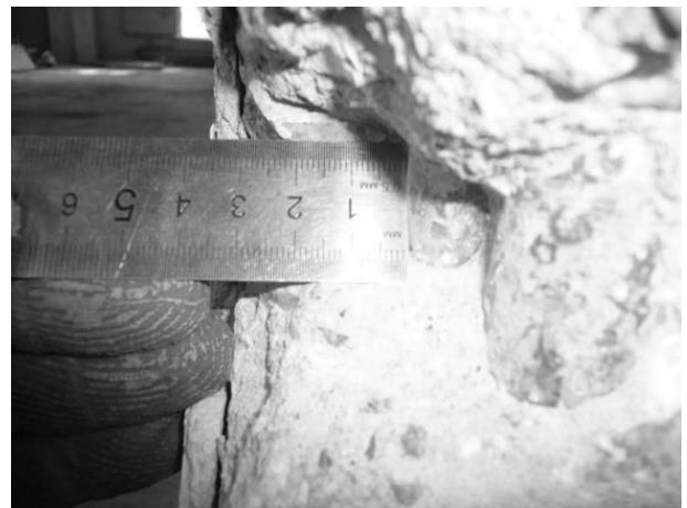
Рис. 5. Величина защитного слоя арматуры 30 мм. Диаметр арматуры 22 мм
