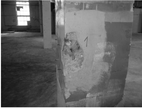
Рис. 2. Участок со вскрытием колонны
