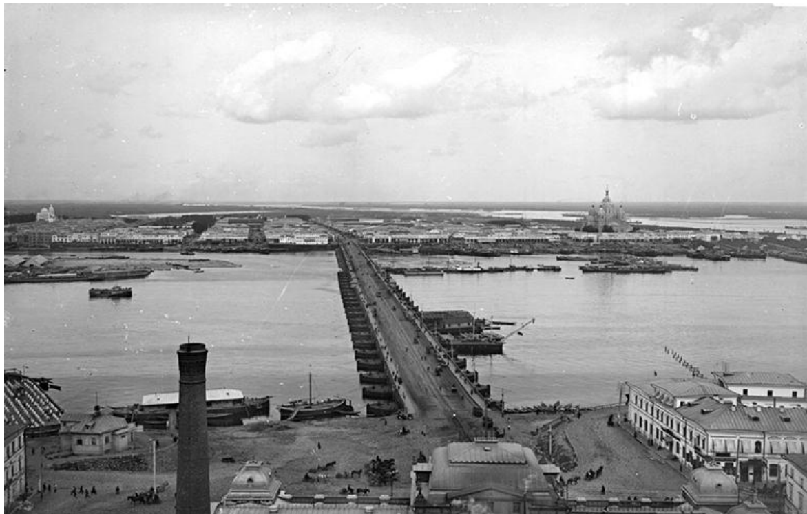
Рис. 2. Вид на плашкоутный мост из-за здания городской электростанции
