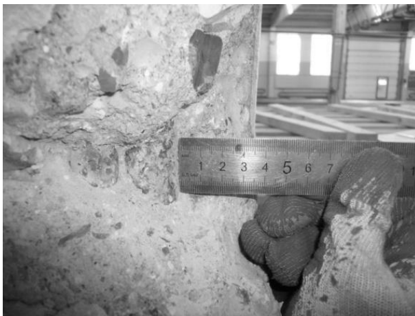
Рис. 4. Величина защитного слоя арматуры 35 мм. Диаметр арматуры 28 мм
