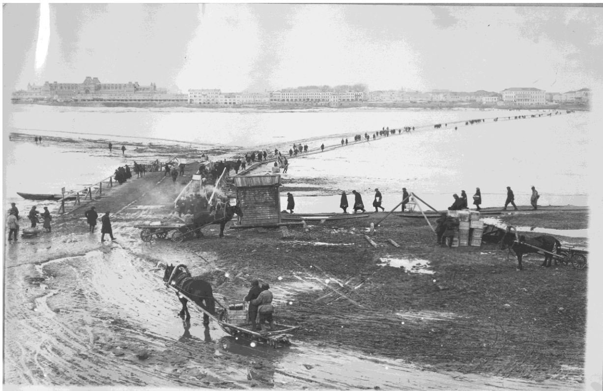
Рис. 1. Весенняя переправа через р. Оку до постройки моста
