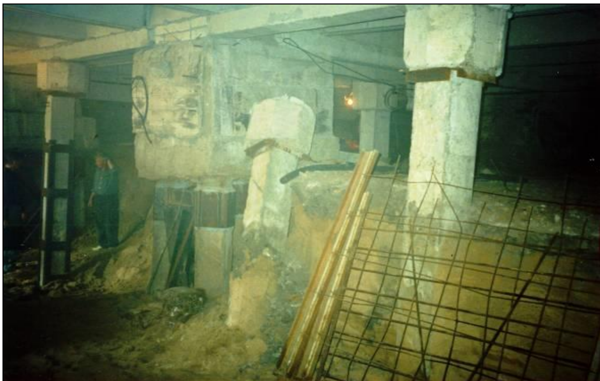
Рис.2. Углубление технического подполья до размеров цокольного этажа с оголением ростверков и свай на высоту до 1,6 м
