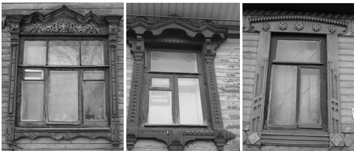
Рис. 1. Геометрические узоры на наличниках, расположенных на фасадах домов в Нижнем Новгороде
