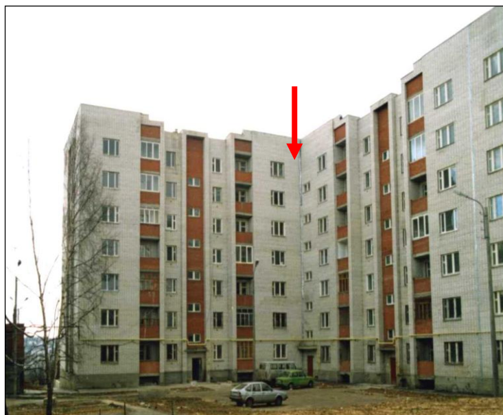
Рис. 2. Сентябрь 1997 года. Секция №1 (на фото слева) и №2 (справа). Деформационные температурные швы, разделяющие здание на 3 температурных блока закрыты нащельниками из оцинкованного железа (рис. 2)
