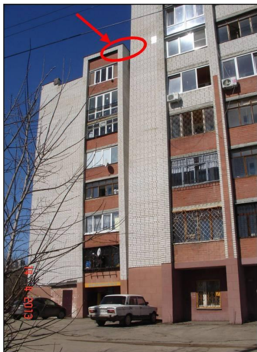
Рис. 4. Апрель 2013 года. Крен секции № 2 по отношению к вертикали угла секции № 1 (вид со стороны оврага)
