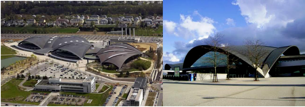
Рис. 3. Пример применения составных пространственных оболочек. Национальный спортивный и культурный центр, г. Люксембург (арх. Роже Тайлибер, 2002)
