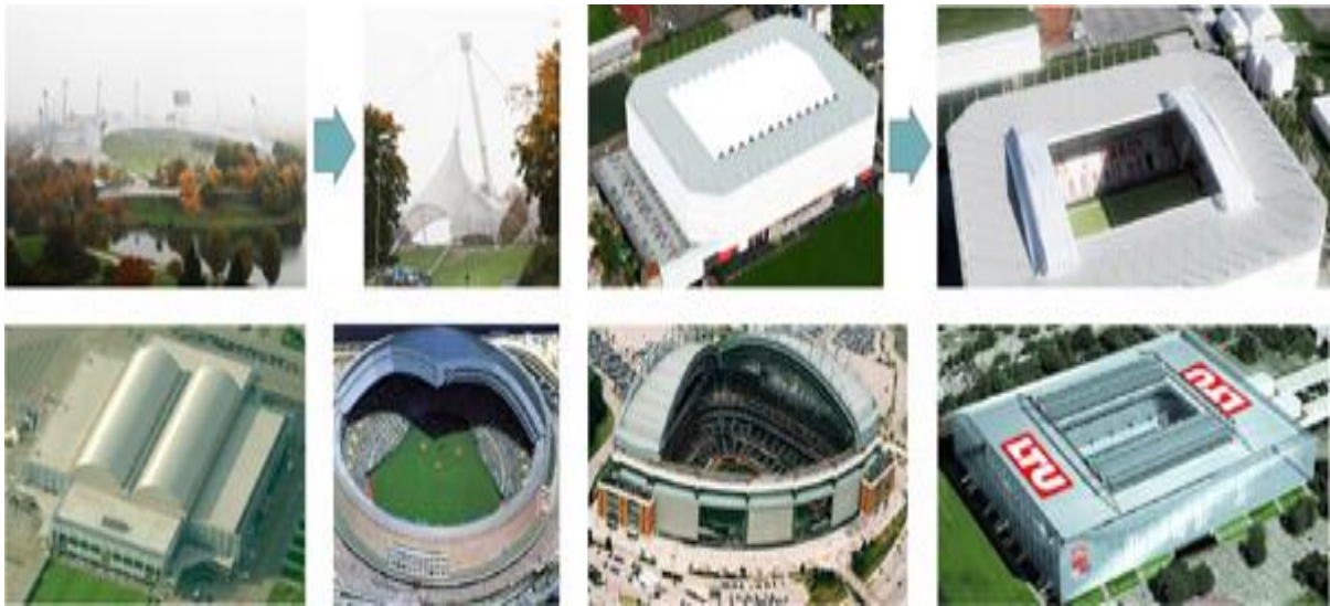
Рис. 2. Виды трансформации кровли в спортивных сооружениях
