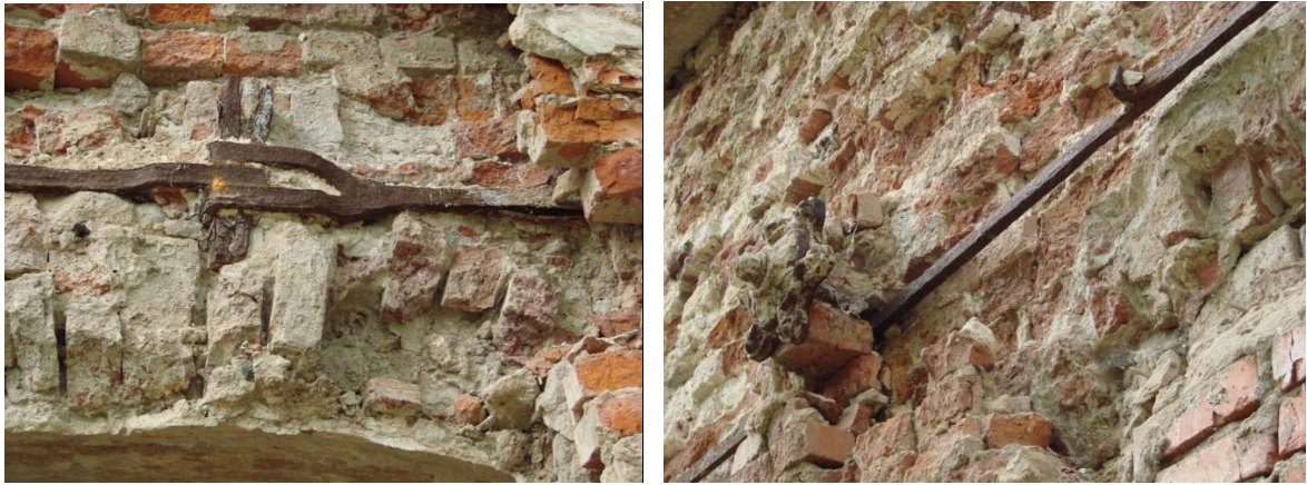
Рис. 3. Железные связи. Фабрика И.К.Коновалова, пос. Бонячки (сейчас район г. Вичуги)
