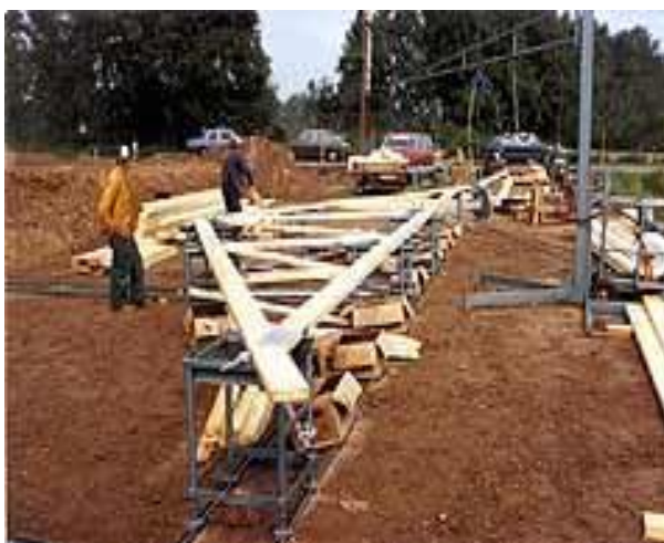
Рис. 2. Изготовление ферм в построечных условиях с помощью подвесной пресс-скобы с кондуктором
