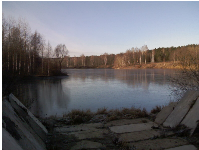
Рис. 1. Вид на пруд из водосбросного сооружения
