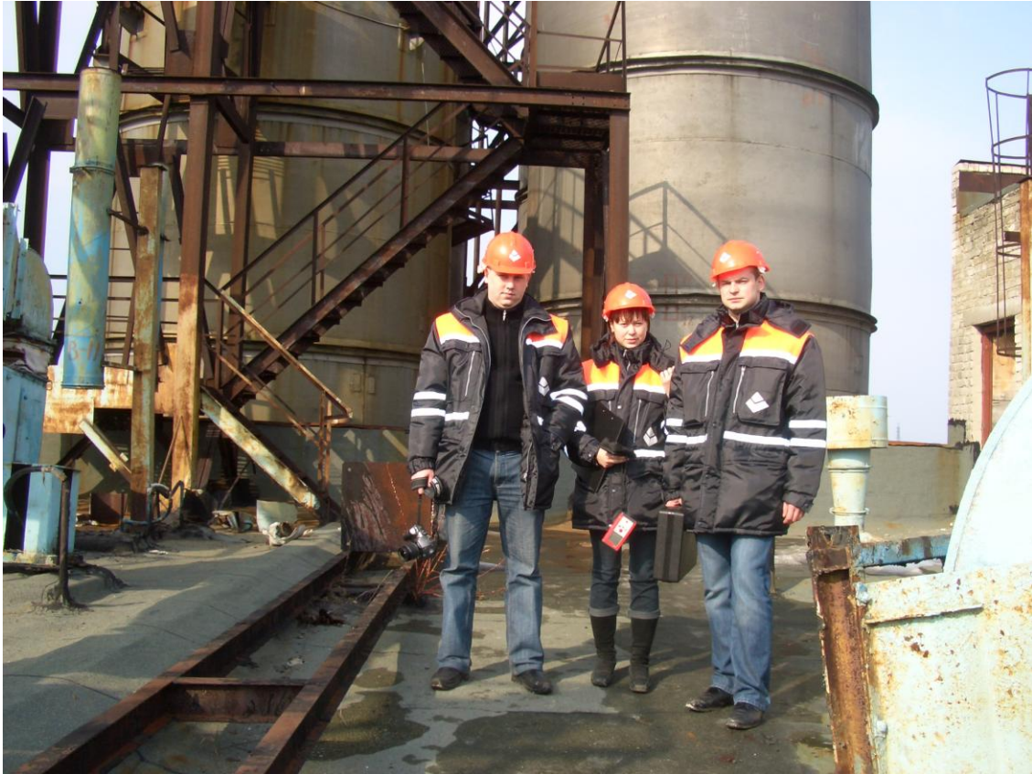
Сотрудники центра экспертизы зданий и сооружений «Промбезопасность» проводят исследования на промышленном объекте
