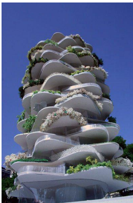
Рис. 1. Пример жилого дома с зелеными балконами, Нидерланды
