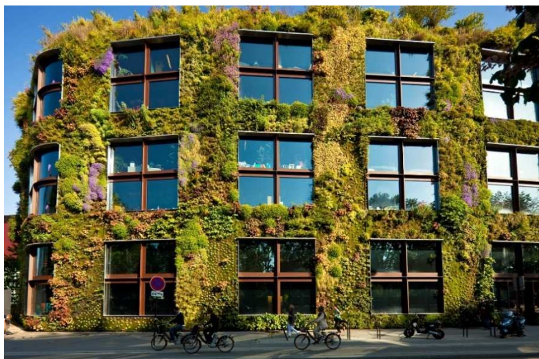
Рисунок 1 – Вертикальное озеленение фасада здания
