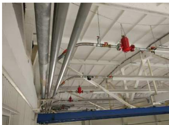
Рисунок 2 – Водяные низкотемпературные инфракрасные излучатели, установленные в производственном помещении
