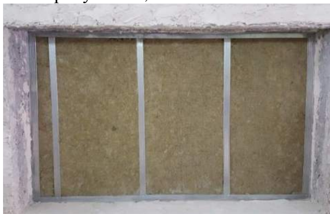
Рисунок 1. Каркасная перегородка
