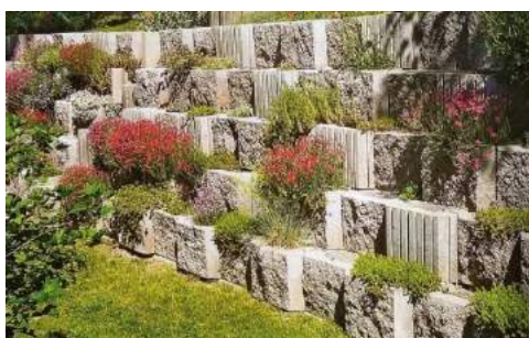
Рисунок 4 – Подпорная стена из пустотелых блоков
