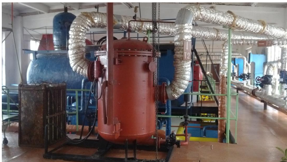
Рис. 1. Электрохимический антинакипной аппарат АЭА-Т-350 с извлечённой кассетой
