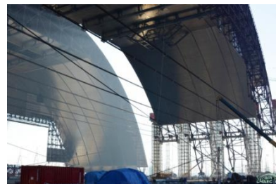
Рис. 6. Возведение нового укрытия 4-го блока ЧАЭС
