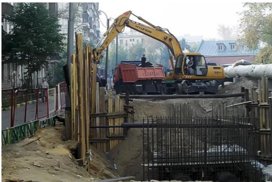
Рис. 5.15. Такую траншею траншеекопателем не выроешь – только экскаватором
