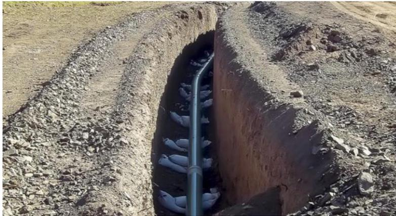
Рис. 5.14. Прокладывание траншеи с вертикальными стенками для укладки труб
