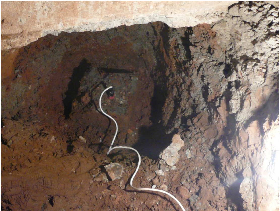
Рис. 12. Схема установки датчиков для проведения испытания свай в подготовленном шурфе
