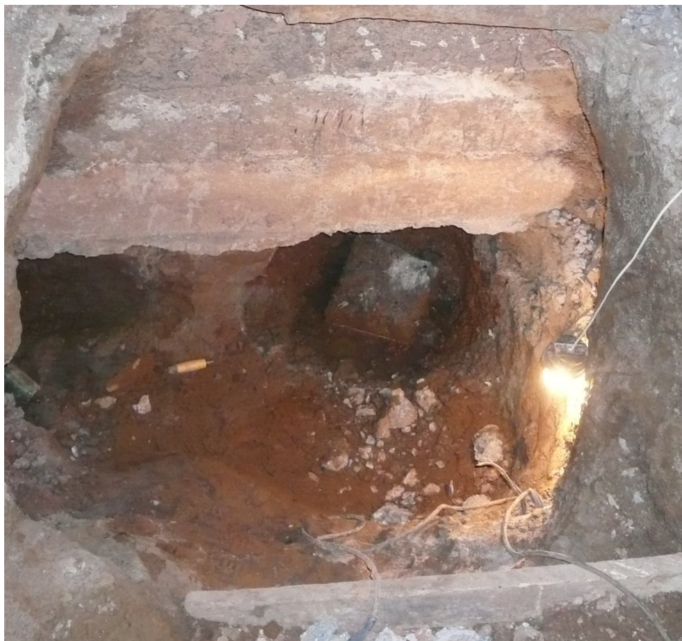
Рис. 10. Общий вид сборной железобетонной сваи, предназначенной для испытания в составе существующей конструкции. Оголовок сваи вырублен из ростверка.
