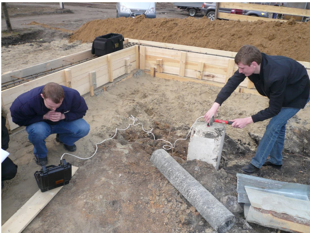
Рис. 13. Процесс проведения исследования длины свай с помощью прибора «ИДС-1»
