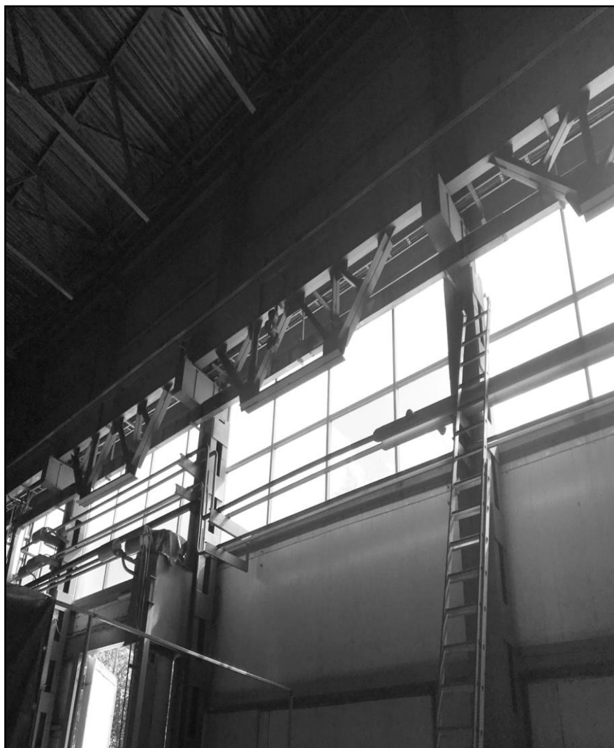
Рис. 11.4. Реализованный проект усиления подкрановых балок пролетом 6 м по ряду «А»
