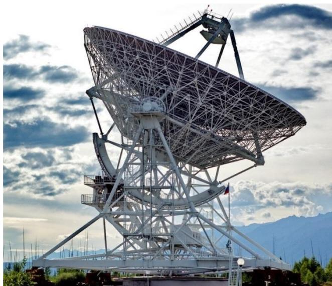
**Рис. 2.20. Катковый радиотелескоп**
