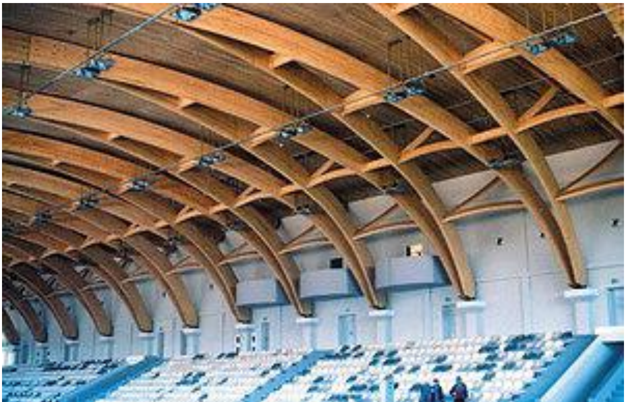
Рис. 6.14. Пересекающиеся арки пролетом 42 м в покрытии спортивного манежа «Подмосковье» в г. Щелково под Москвой
