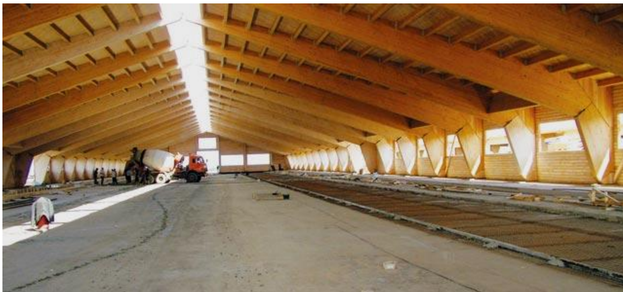
Рис.7.12. Пример применения рам при строительстве здания сельскохозяйственного назначения
