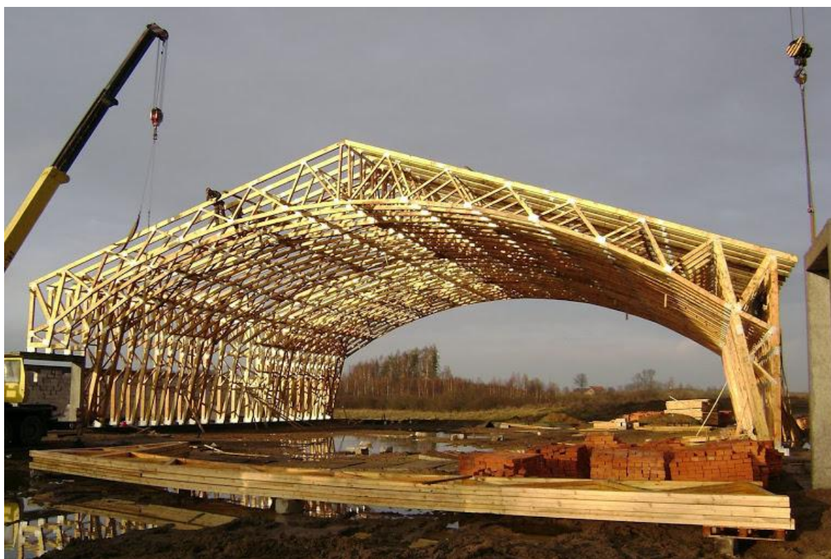
Рис. 7.10. Двухшарнирные рамы из досок с соединениями в узлах на МЗП
