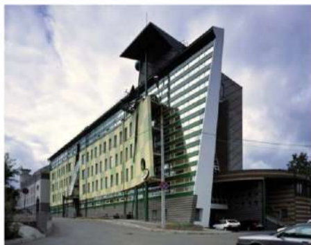
Рис. 1. Офисное здание на Почайнском овраге
