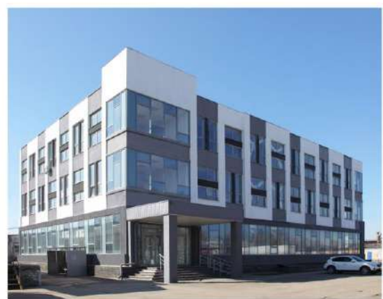
Рис.16. Офисное здание на пр.Базовом,1
