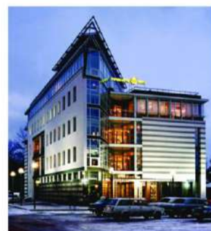
Рис. 4. Офисное здание на ул. Октябрьской,33
