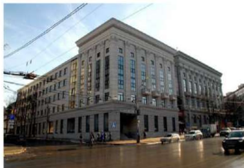
Рис. 2. Офисное здание на пл. Горького,36-а
