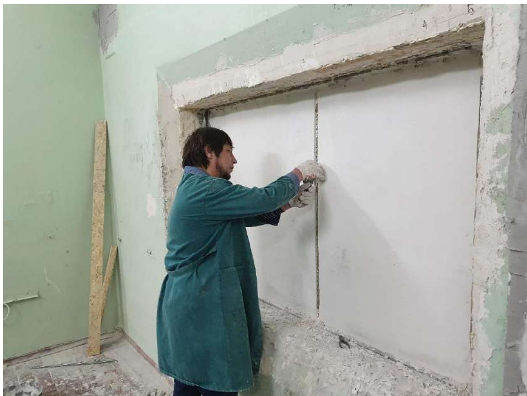
Рис. 1. Демонтаж маяков из торкрет-облицовки исследуемого образца
