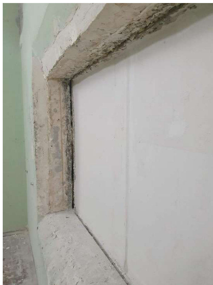
Рис. 1. Демонтаж маяков из торкрет-облицовки исследуемого образца
