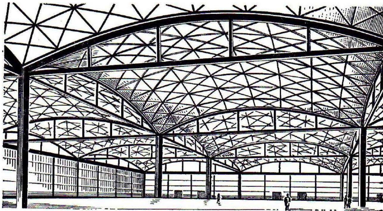
Рис.6.17. Интерьер цеха, перекрытого оболочками двойкой кривизны
