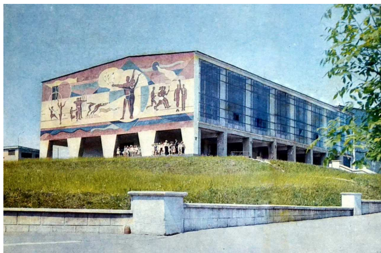
Рис. 1.2. Типовое здание спорткомплекса с бассейном в СССР, 1960-е гг.
