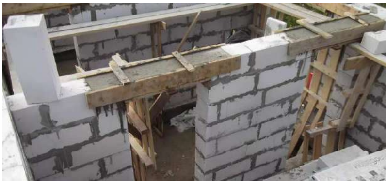
Рисунок 39 – Монолитная железобетонная перемычка над дверным проемом
