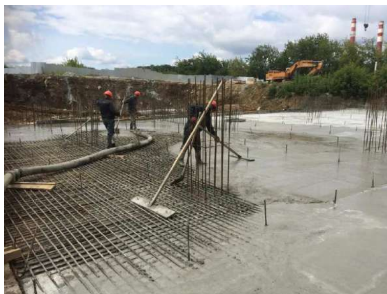
Рисунок 36 – Процесс заливки бетона при производстве монолитной фундаментной плиты
