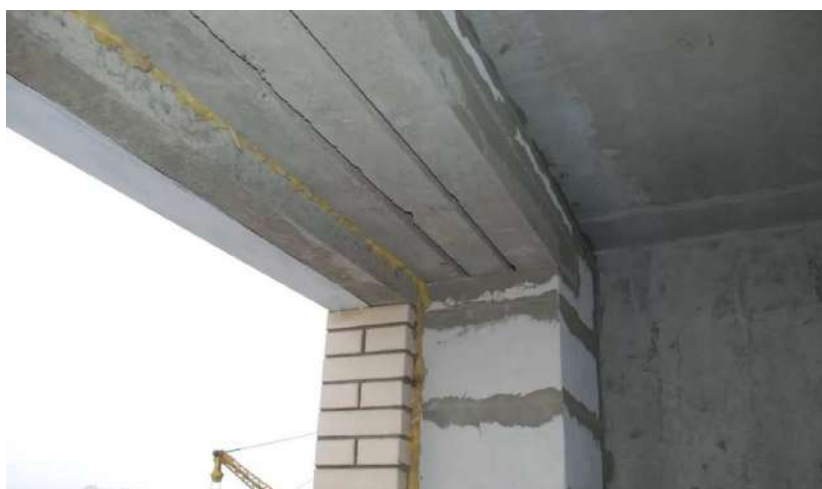
Рисунок 38 – Сборные железобетонные перемычки над оконным проемом
