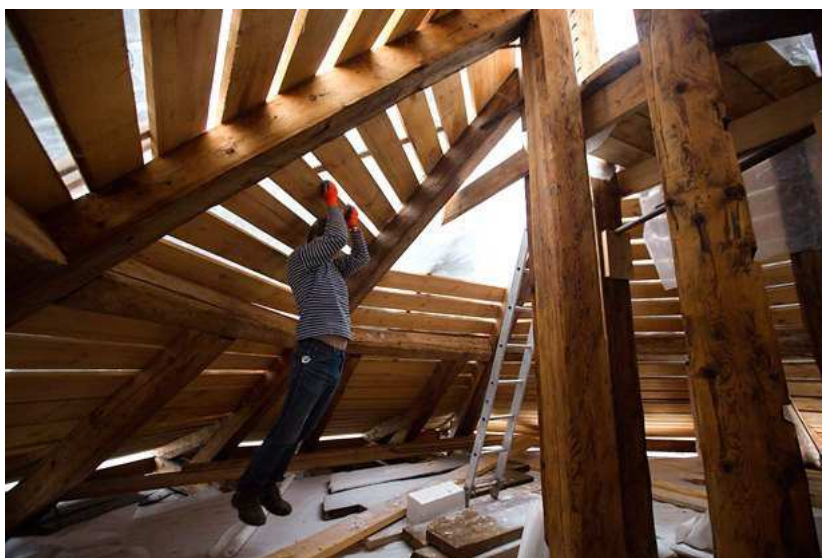
Рисунок 2.10.4 – Монтаж новой кровли, исторические стропила. Источник: https://zen.yandex.ru/blogstroitelja
