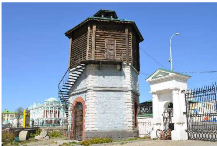
Рисунок 2.1.1– Водонапорная башня на Плотинке – Екатеринбург. Источник: https://commons.wikimedia.org/
