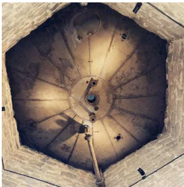
Рисунок 2.1.3– Дно резервуара – вид с 1 этажа. Источник: https://ekaterinburg.flamp.ru/
