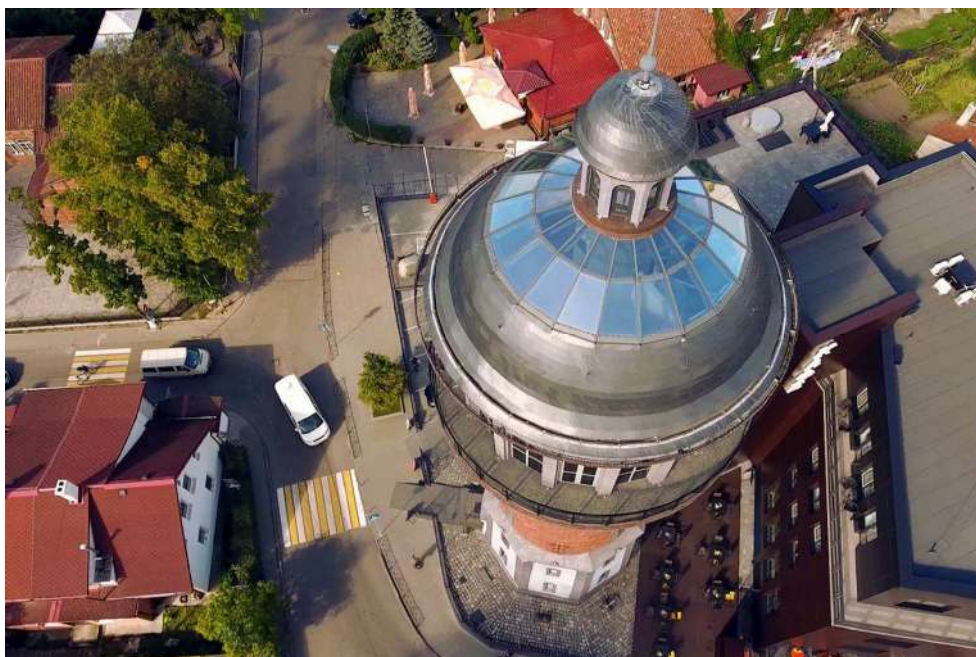
Рисунок 2.5.3 – Устройство кровли Зеленоградской башни. Источник: https://murarium.ru/
