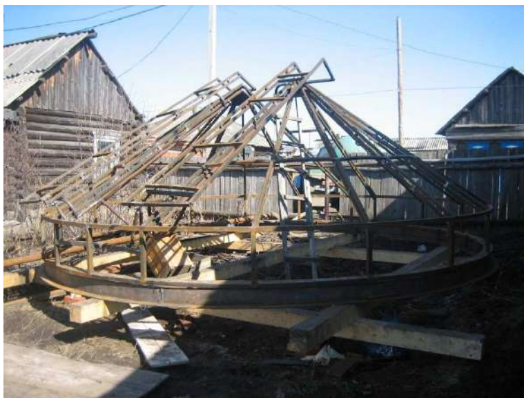
Рисунок 2.2.3 – Металлический каркас купола. Источник: https://vk.com/astro_tower
