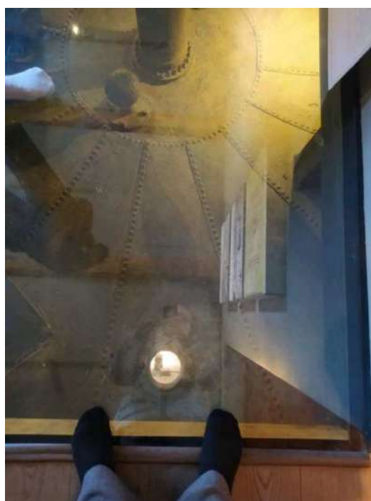
Рисунок 2.1.4– Дно резервуара – вид с 2 этажа. Источник: https://ekaterinburg.flamp.ru/
