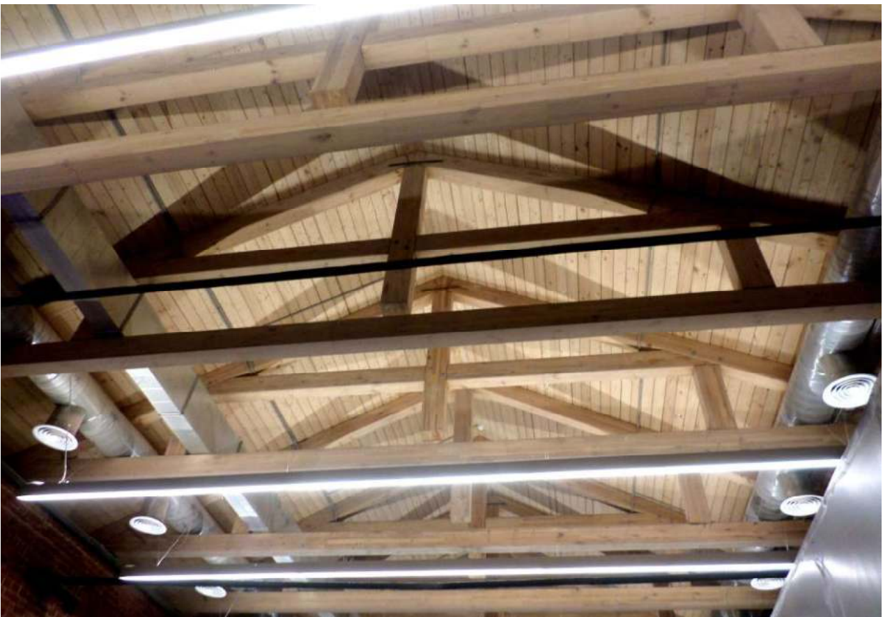
Вид открытых стропильных конструкций выставочных залов. Фото 2019 г.
