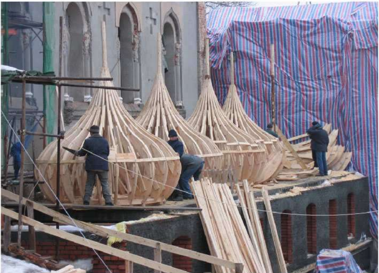
Реставрация глав. Проектные чертежи 2004 г. (вверху), вид глав на строительной площадке. Фото 2005 г.
