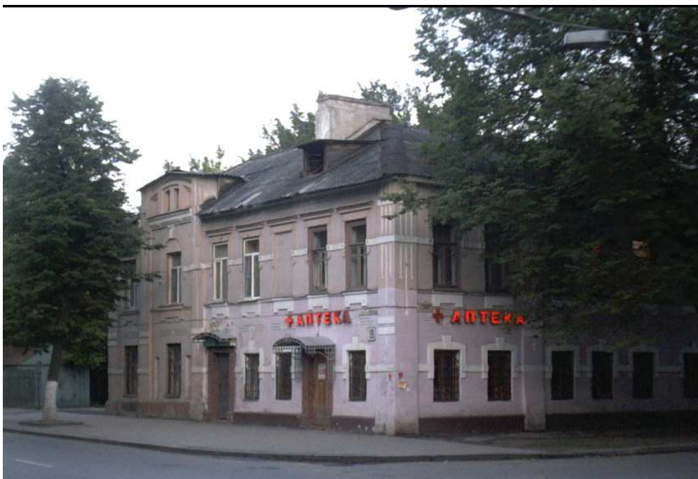
Вид дома до реконструкции. 2003 г.
