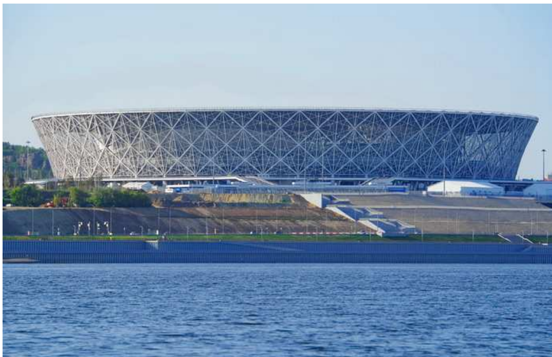
Рис. 2.7. Берегоукрепительные работы рядом с «Волгоград Ареной»
