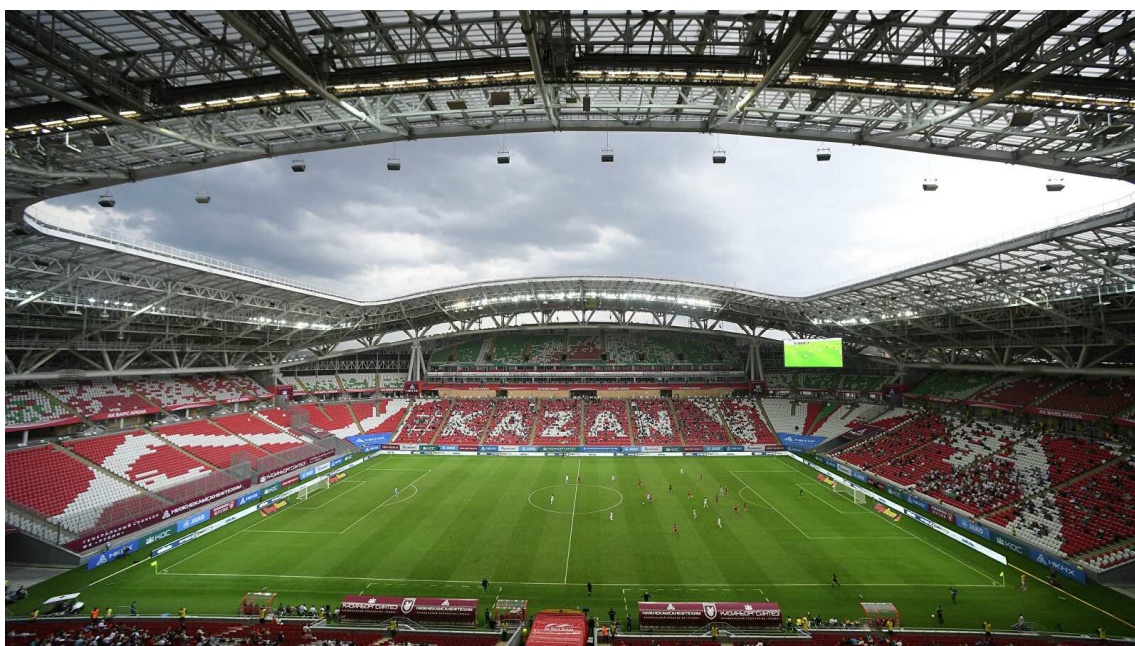
Рис. 2.38. 120 метровые пролеты на стадионе «Ак Барс Арена»
