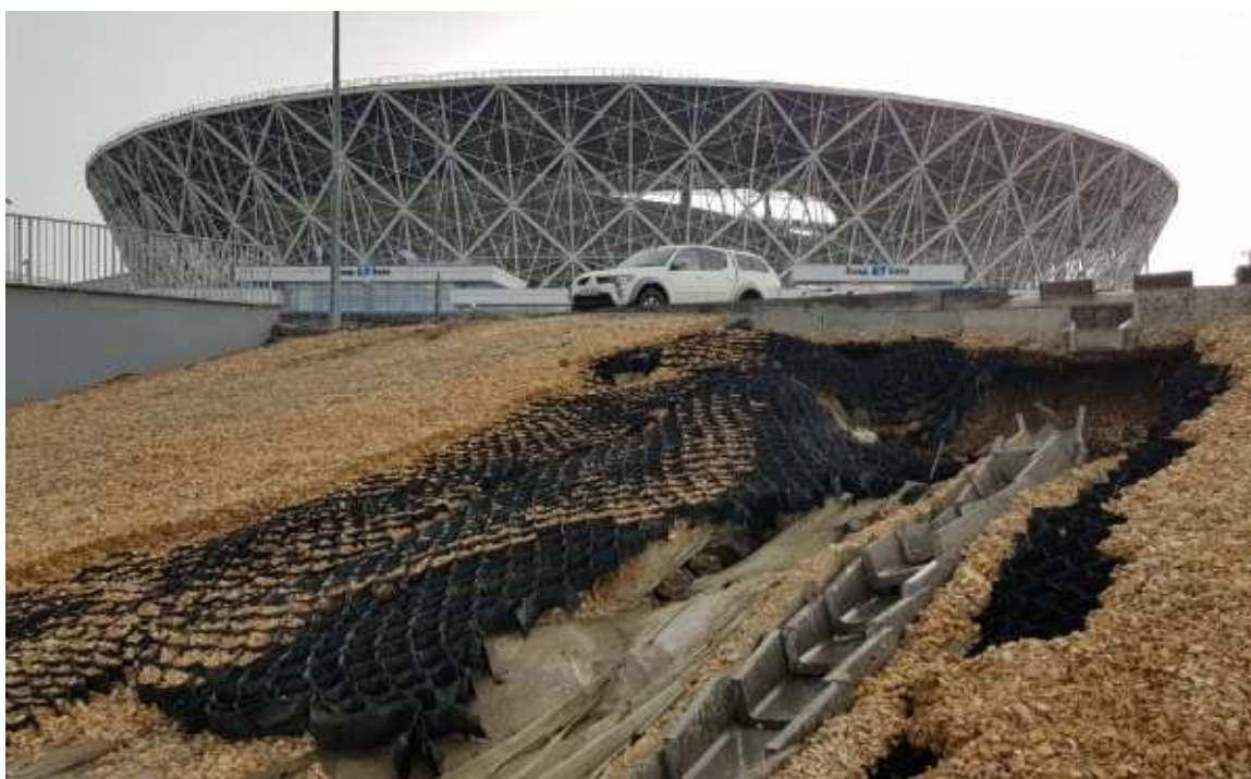
Рис. 2.6. Размыв грунтов рядом с «Волгоград Ареной»
