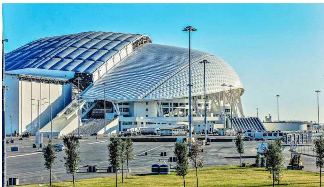
Рис. 2.3. Фотополимерная пленка на центральной части стадиона «Фишт»
