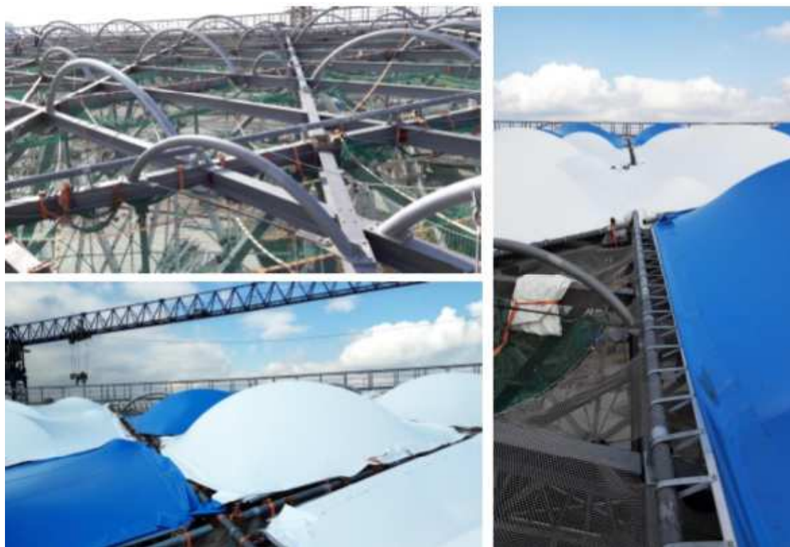
Рис. 2.16. Способ закрепления мембран над фойе на кровле стадиона «Волгоград Арена»
