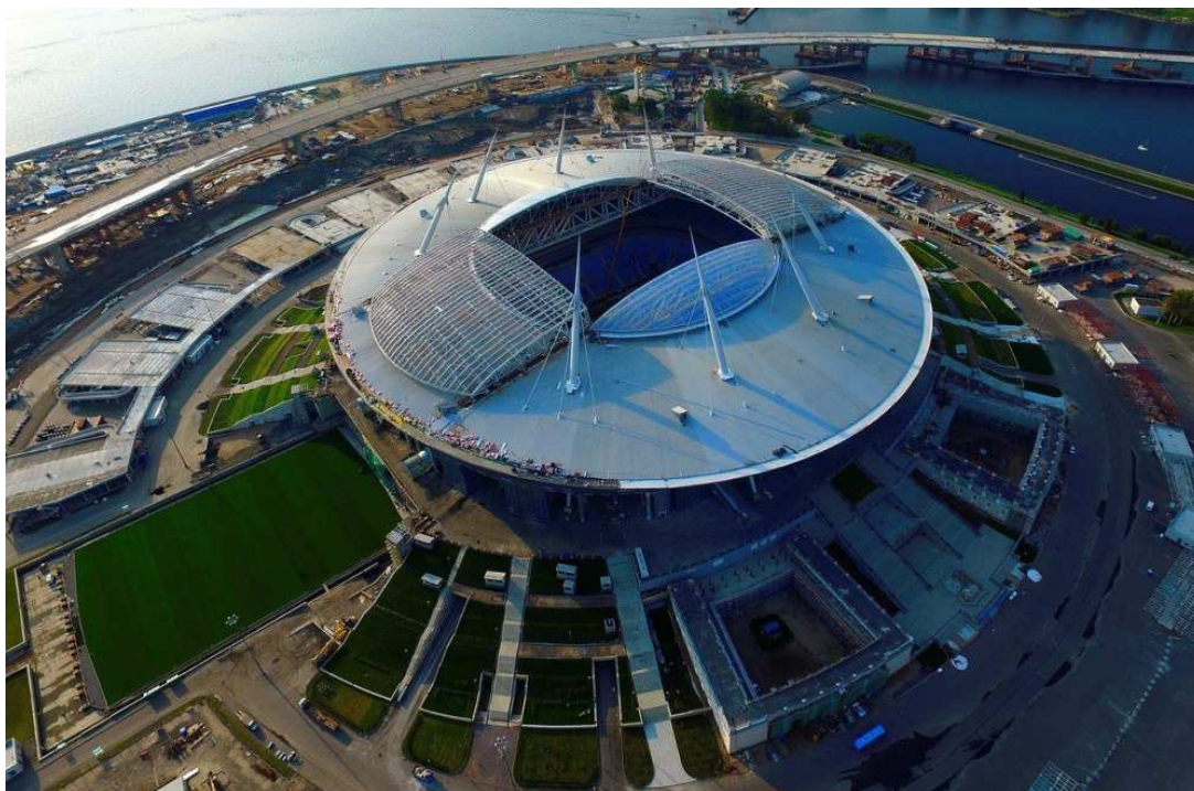
Рис. 2.20. Выкатное поле и раздвижная крыша стадиона «Газпром Арена»
