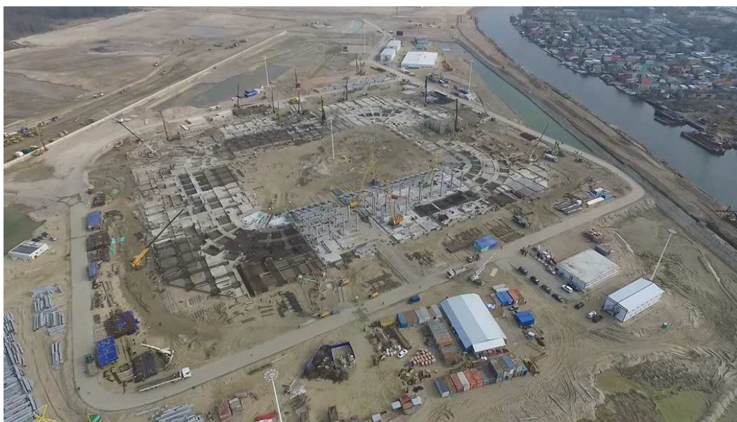
Рис. 2.5. Начало строительства «Калининград Арены» на сложной заболоченной местности
