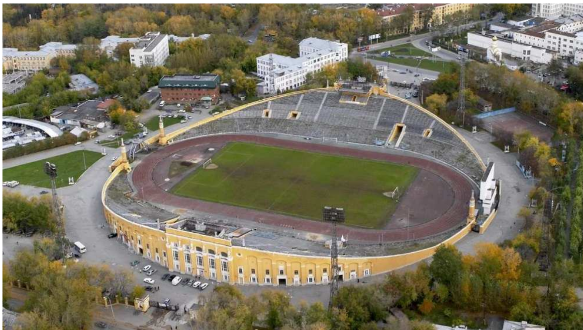
Рис. 1.14. Стадион «Центральный» в Екатеринбурге до реконструкции
