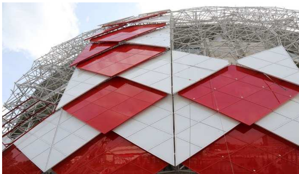
Рис. 2.18. Стеклопанели Planibel Clearvision на фасаде стадиона «Открытие Арена»
