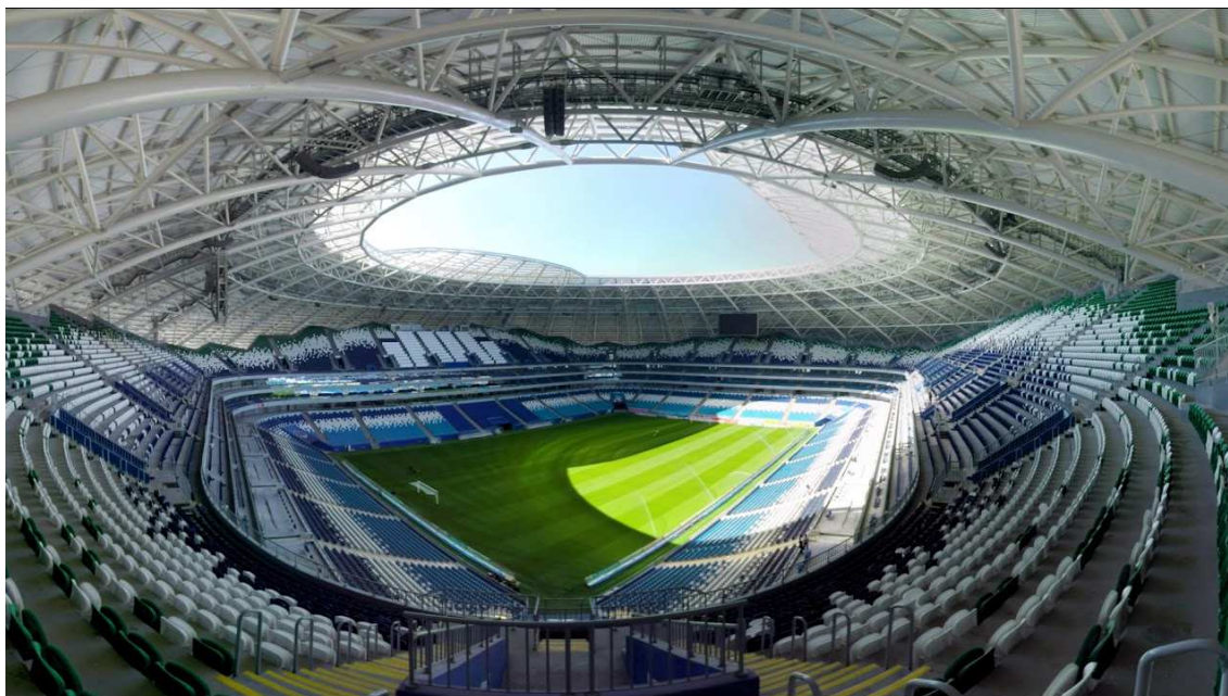
Рис. 2.35. Устройство трибун на стадионе «Самара Арена»
