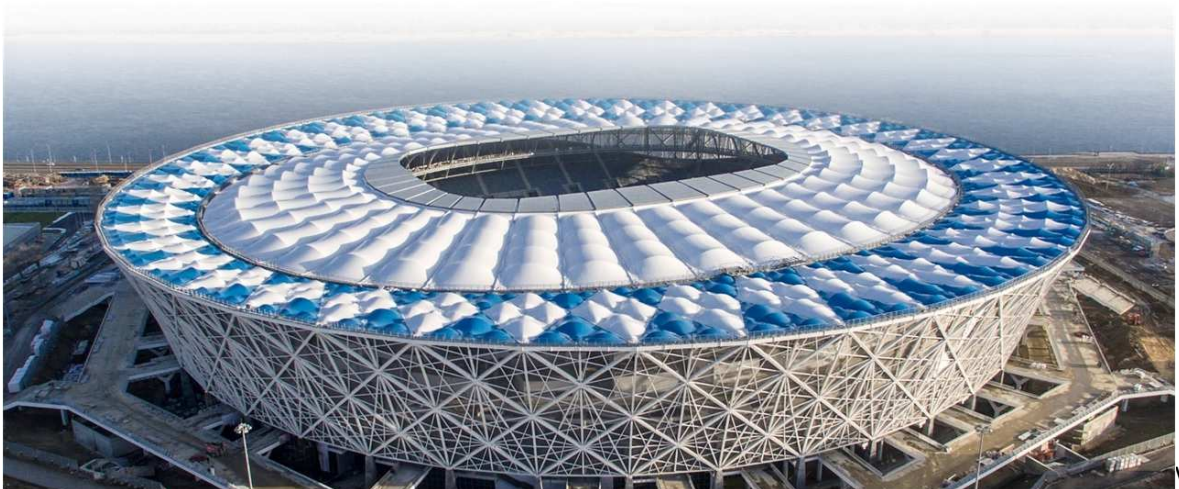
Рис. 2.14. Вантово-мембранная кровля стадиона «Волгоград Арена»
