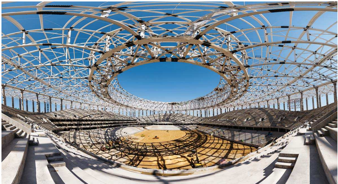
Рис. 2.10. Каркас крыши стадиона «Нижний Новгород»
