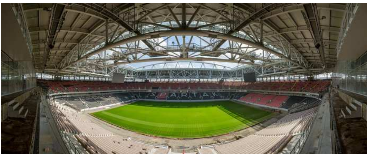
Рис. 2.17. Стальные фермы на крыше стадиона «Открытие Арена»
