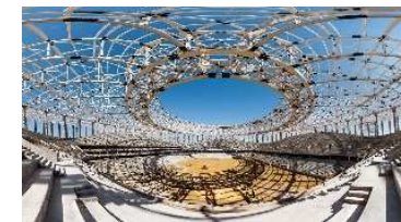
Каркас крыши стадиона
