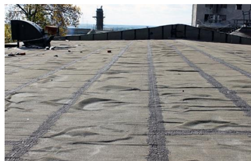
Рис. 60. Растрескивание битумной поверхности
