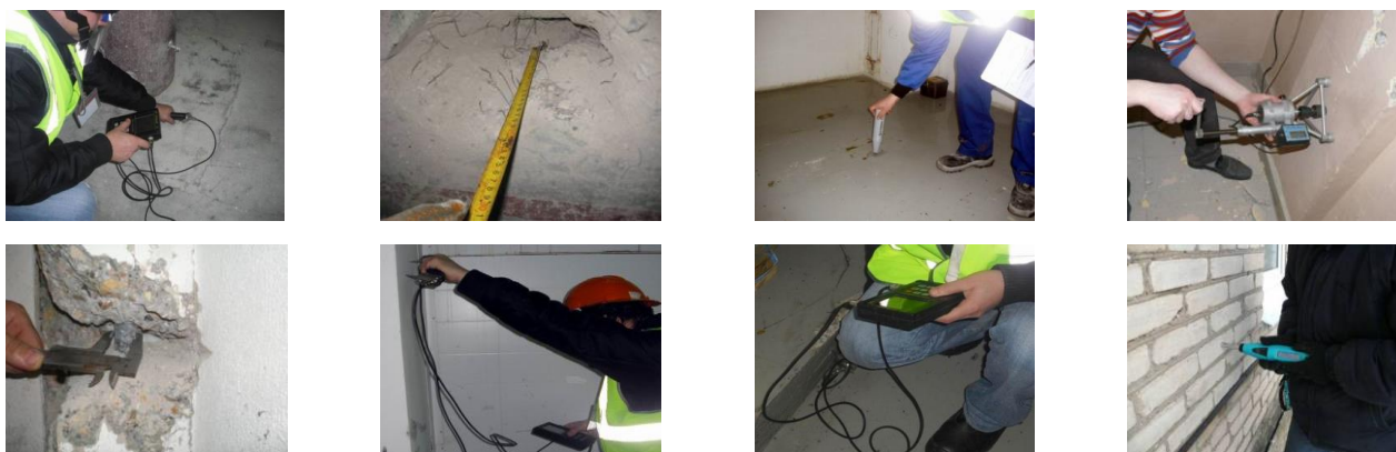
Рис. 25. Детальное (инструментальное) обследование технического состояния здания.
