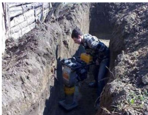
Рис. 27. Поверхностное усиление оснований фундаментов
