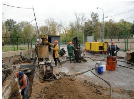
Рис. 30. Химический способ закрепления грунтов, смолизация грунтов: 1-инъектор, 2-рабочий шланг, 3-манометр, 4-рабочий бачок, 5-пробковый кран, 6- компрессор или баллон со сжатым воздухом.
