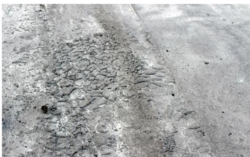
Рис. 60. Растрескивание битумной поверхности
