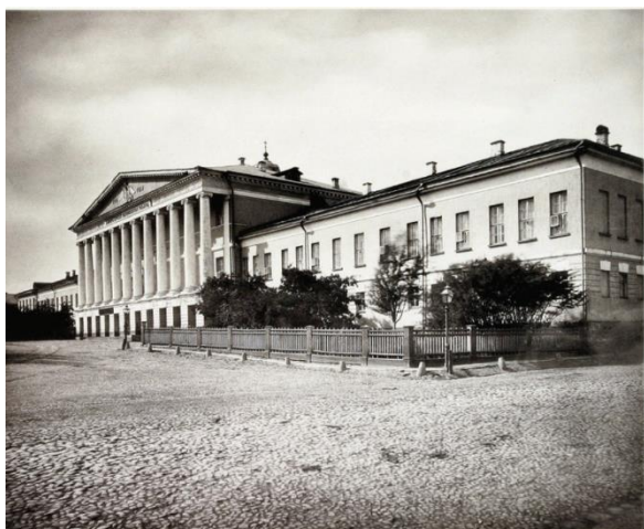
Главный фасад, 1884 г.
