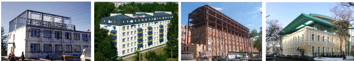
Рис.5. Архитектурно-конструктивные приемы реконструкции зданий.
