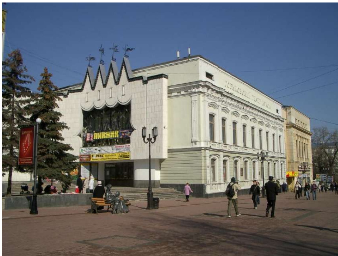
Рис. 6. Театр кукол (реконструкция жилого дома XIX в.), ул. Б. Покровская, 39, арх. С.А. Тимофеев, 1979 г.
