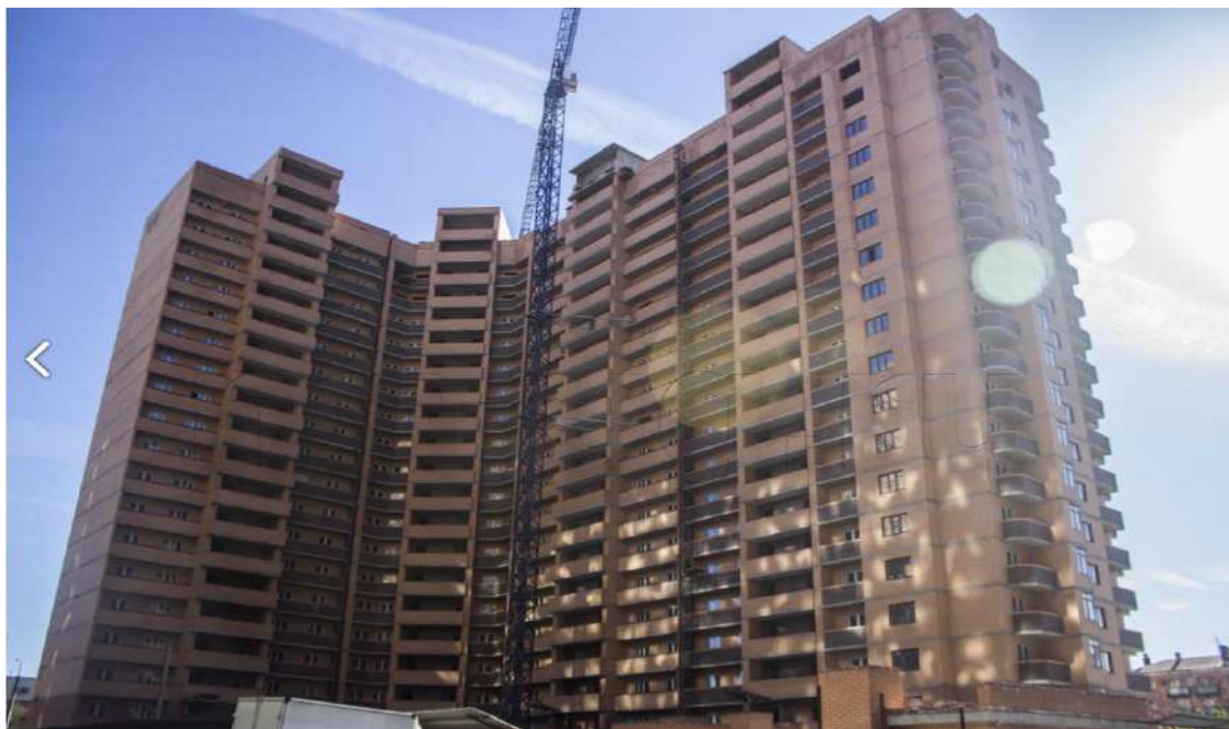
Рис.5. Этап строительства здания. Ноябрь 2017 г.
