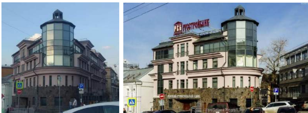
Рис. 141. Пример реконструкции с вставкой нового объема исторического доходного дома в г. Москва
