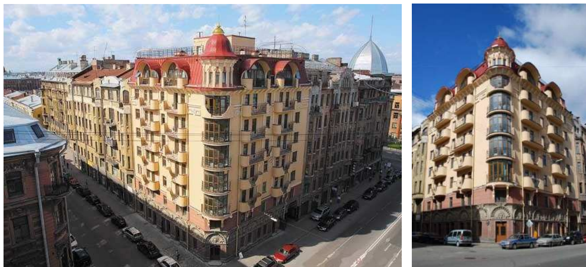
Рис. 151. Элитный жилой дом в г. Санкт-Петербург, арх. Н.В. Питанин, А.Б. Семенова
