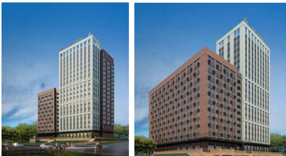
Рис. 7. ЖК «КМ Tower» в г. Нижний Новгород
