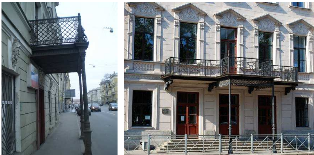
Рис. 113. Слева – металлический навес-«зонтик» доходного дома. Справа – металлический навес-«зонтик» доходного дома, 1845 – 1847 гг., арх. И.Д. Корсини
