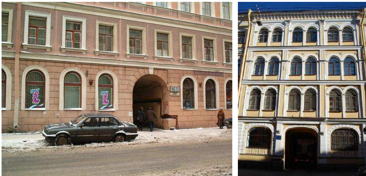
Рис. 98. Доходные дома на ул. Декабристов. Фрагменты фасадов. Стены первых этажей обработаны рустом. Слева – дом № 16, 1847 г., арх. Н.П. Гребенка. Справа – дом № 18, 1851 г., арх. А.И. Ланге
