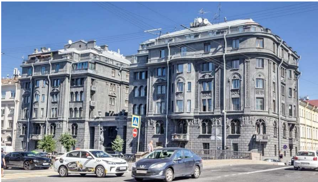
Рис. 121. Доходный дом Р.Г. Вега в г. Санкт-Петербург, 1912 – 1914 гг., арх. С.О.
