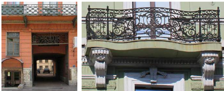
Рис. 111. Слева – балкон дома купца Юнкера (1840 – 1841 гг., арх. Г.-Р. Цолликофер).
