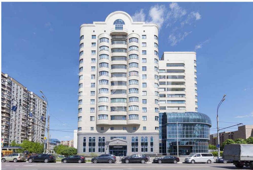
Рис. 123. ЖК «Дом Газпрома» в г. Москва
