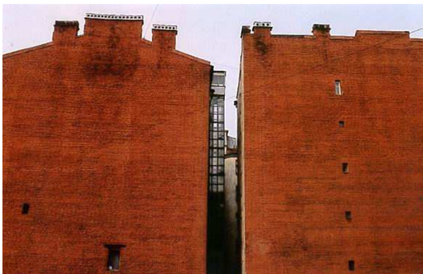
Рис. 71. Брандмауэрная стена
