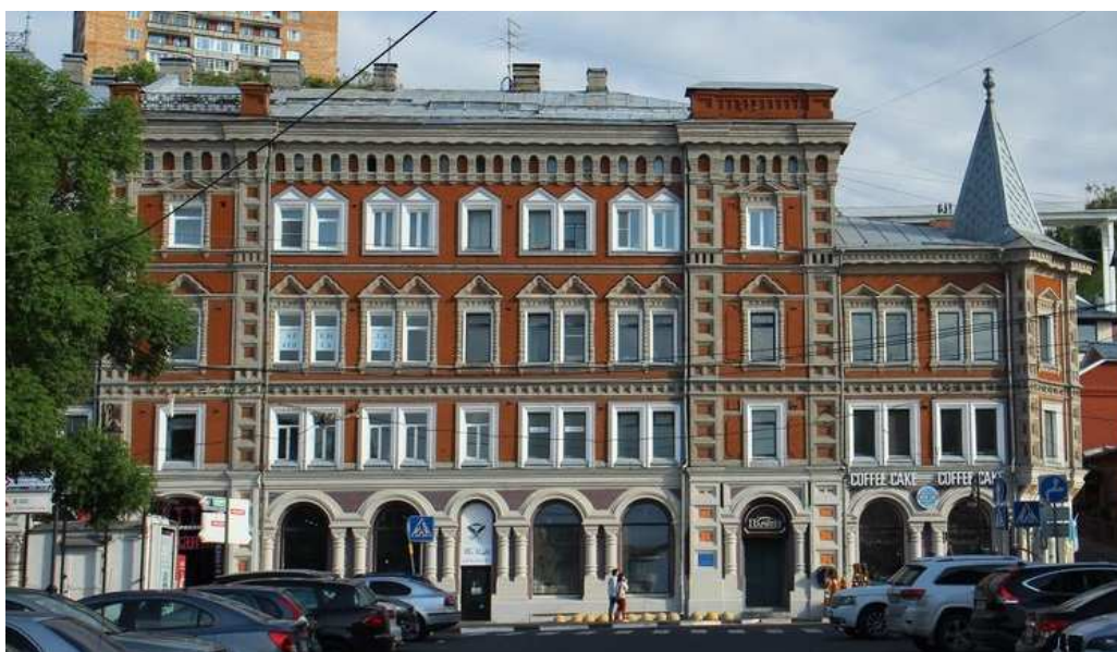
Рис. 129. Доходный дом «Блиновский пассаж» в г. Нижний Новгород, 1878 г., арх. А.К. Бруни
