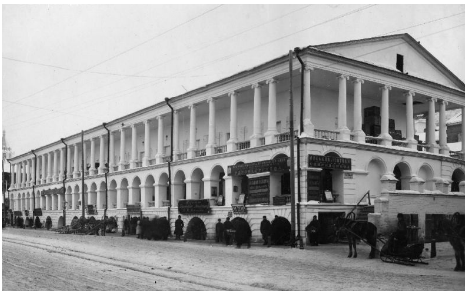
Рис. 14. Корпус гостиного двора (торговые ряды) с галерейной планировкой в г. Нижний Новгород, конец XIX века
