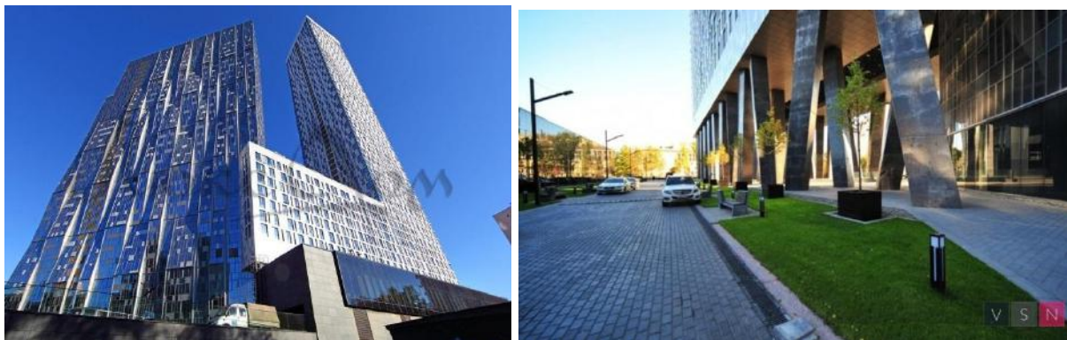
Рис. 2.19. ЖК «Дом на Мосфильмовской» г. Москва
