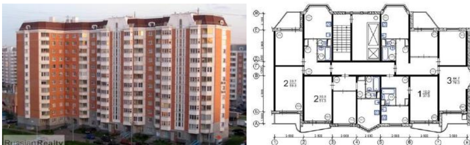
Рис. 2.7. Крупнопанельный дом серии П44Т. 1998 г. Москва. Общий вид, План типовой жилой секции
