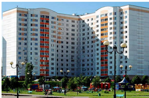
Рис. 2.5. Крупнопанельный дом серии П55М. 1997 г. Москва. Общий вид
