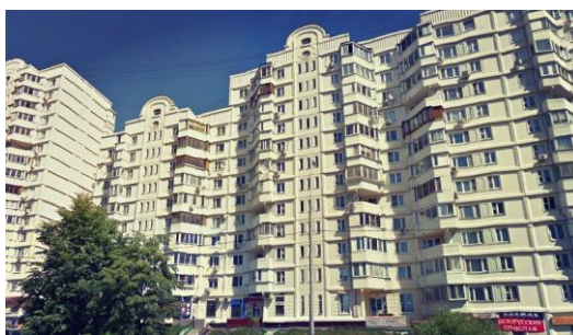
Рис. 2.3. Крупнопанельный дом серии ПД-4. 1994 г. Москва. Общий вид
