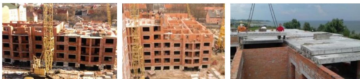
Рис.1.6. Строительство жилого дома с каменными стенами, г. Калининград, 2014 г.
