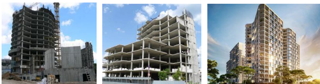
Рис. 2.19. Примеры строительства многоэтажных зданий с монолитным железобетонным каркасом
