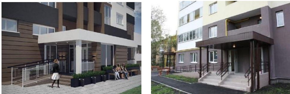
Рис. 1.58. Фрагменты входов многоэтажных жилых зданий
