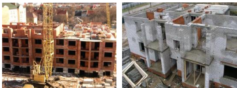
Рис. 2.11. Строительство жилого дома с каменными стенами
