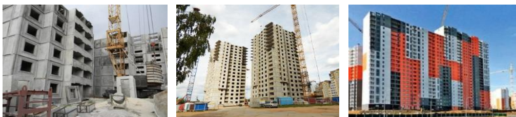
Рис. 1.7. Строительство многоэтажного крупнопанельного жилого дома
