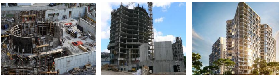
Рис. 1.8. Строительство многоэтажных жилых домов в монолитном железобетоне
