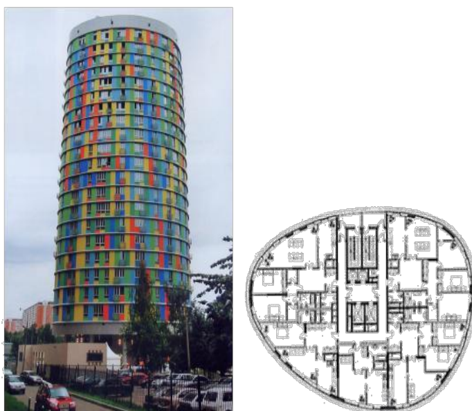
Рис.2.22. Монолитный жилой дом с использованием щитовой переставной опалубки. Арх. С.Кисилев. Москва, жилой дом «Авангард». Общий вид, план типового этажа
