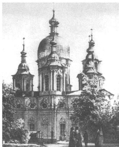
Вид Троицкого собора. Фото, начало XX в.
