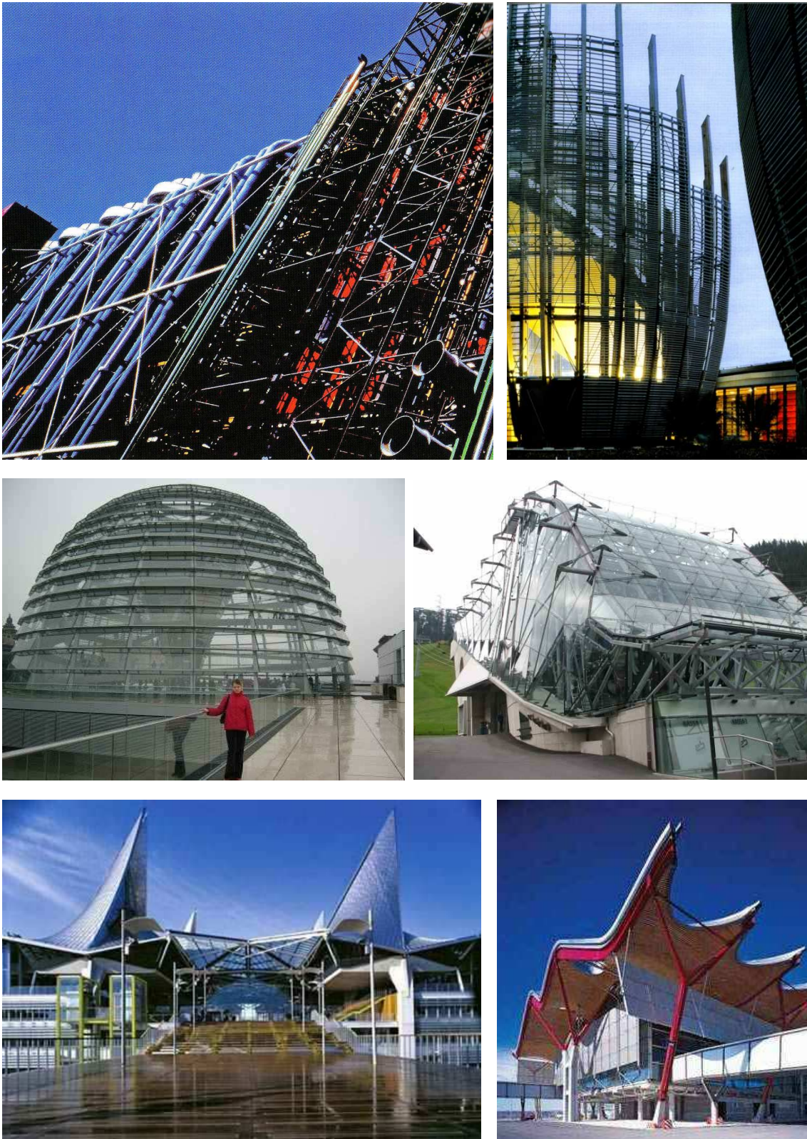
Рис. 34. Архитектурные произведения, выполненные в стиле хай-тек (слева направо, сверху вниз: Центр Ж. Помпиду в Париже (Р. Пиано, Р. Роджерс, 1971-77 гг.), Культурный центр в Нумеа (Новая Каледония, Р. Пиано, 1991-98 гг.), купол рейхстага в Берлине (Н. Фостер), Посадочная станция для канатной дороги, здание Суда в Антверпене и Аэропорт в Мадриде (Р. Роджерс))
