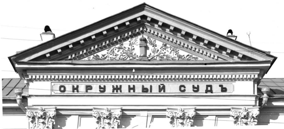
Рис. 3. Вид фронтона центрального портика с барельефом в тимпане. Фото начала XX в.
