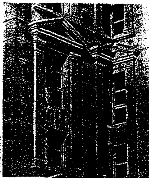
Рис. 3. Жилой комплекс «Антигона» в Монпелье. Фрагмент фасада Арх. Р. Бофилл
