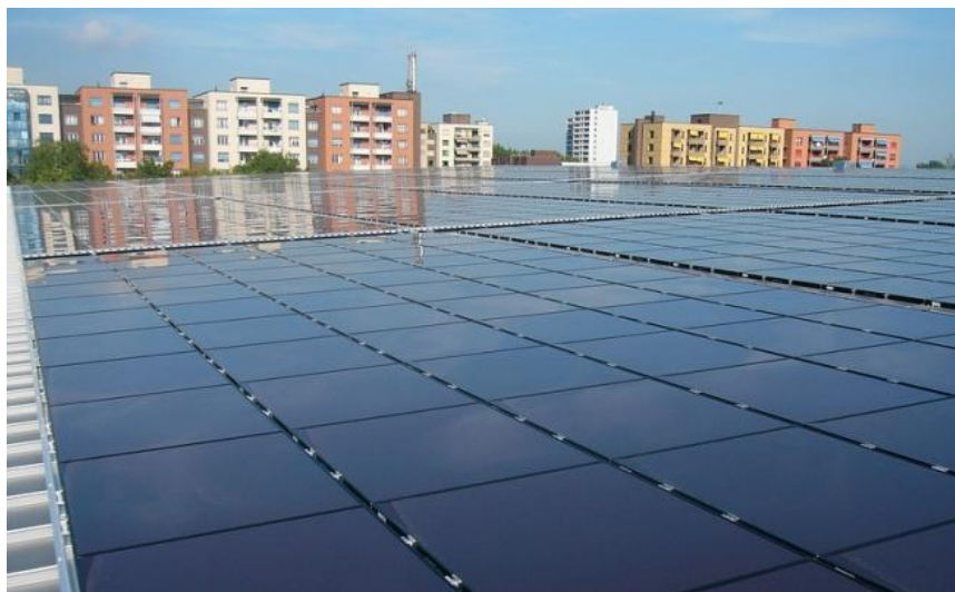
Рис. 30. Элементы солнечных батарей на крыше «Боссард Арены»
