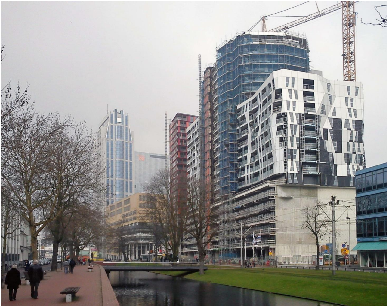
Рис. 2.43 Роттердам. Нидерланды. Строящиеся объекты на подходе к центральному вокзалу
