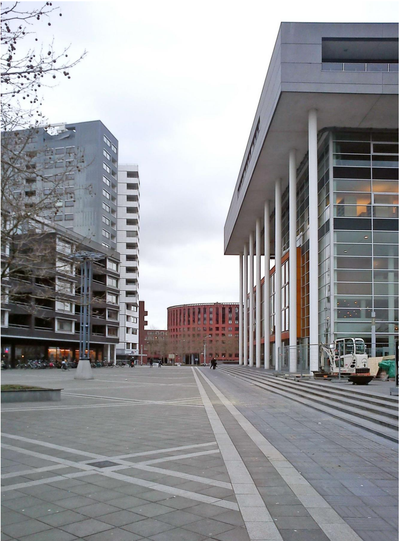
Рис. 2.37 Маастрихт. Нидерланды. Слева направо: жилой дом (А. Сиза, 1999 г.), административно-жилое здание «Крепость» (La Fortezza, М. Бота, 2000 г.), культурный Центр «Керамик» (Йо Коэнен, 1999 г.)
