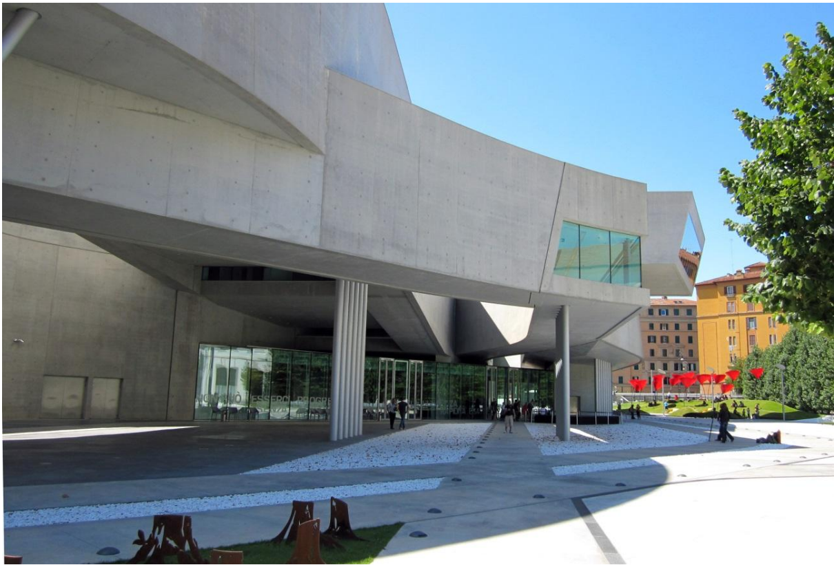
Рис. 2.21 Национальный музей искусства XXI века в Риме «МАХХИ», З Хадид, конкурс 1998 г., строительство: 1999-2010 гг. Благоустройство входной зоны музея
